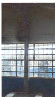
Foto 3: Sustrucción de chimenea de metal por chimenea de ladrillo.
