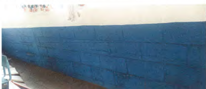
Foto 5: Sabieta un área de 90 centímetros de ancho por 26 metros de largo por humedad, abarca parte de 3 aulas.
