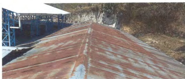
Foto 1: Sustrucción de lamina acanalada por lamina troquelada de 6 aulas y 2 bodegas
