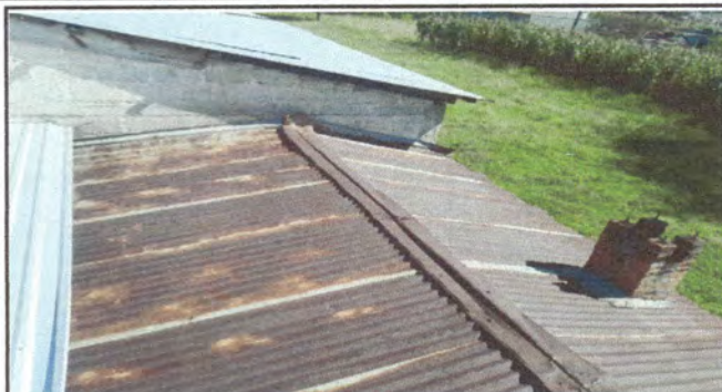
Foto 1: Sustitución de lámina acanalado por lámina troquelada y nivelación de altura a galera ya existente
