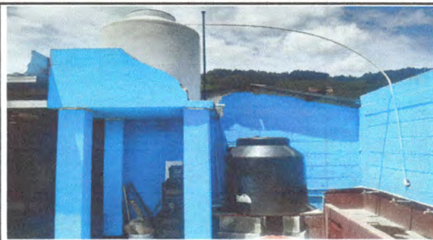
Foto 6: Sustitución de tinaco de agua y mantenimiento de línea hidráulica de lavamanos
