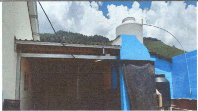
Foto 10: Instalación de tubo de 4" como canal para galera y cocina
