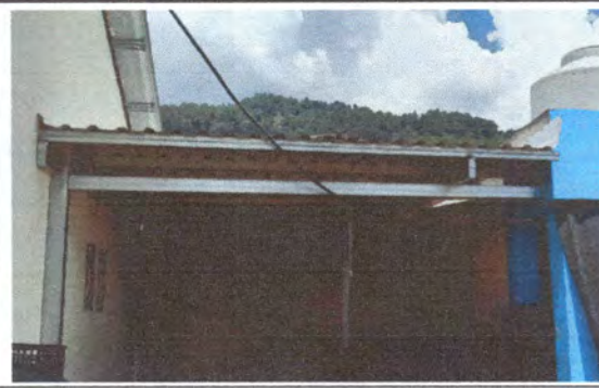
Foto 8: 2 Puertas de metal a entrada de galera. Una puerta en cada extremo de la galera
