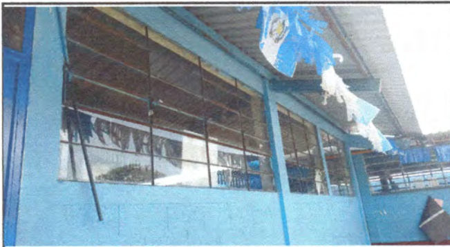
Foto 9: Instalación de balcones en aula modulo 2
