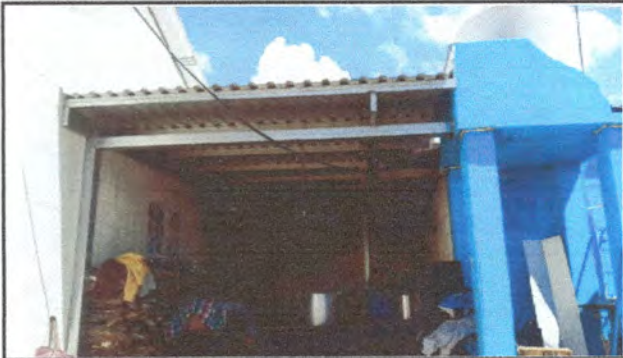
Foto 7: Cierre de entrada de galera con tabla de fibrocemento con recubrimiento de blanqueado fino
