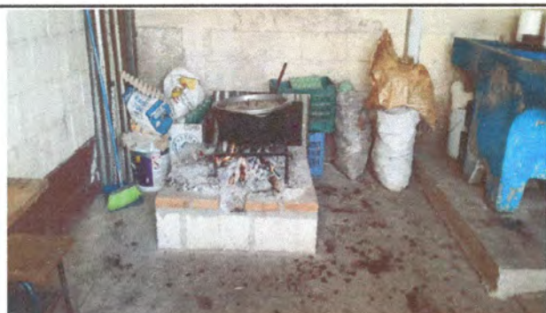
Foto 3: Sustitución de plancha en cocina por 3 planchas pequeñas de 2.00 largo total X 1M ancho en un solo cuerpo funcionalidad individualmente
