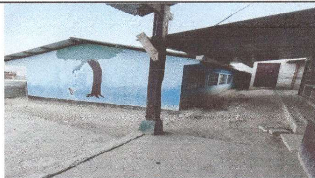
Foto 2: INSTALACION DE PISO DE TORTA DE CONCRETO, REPARACION DE ESCUADRA PARA SOSTENER CANAL
