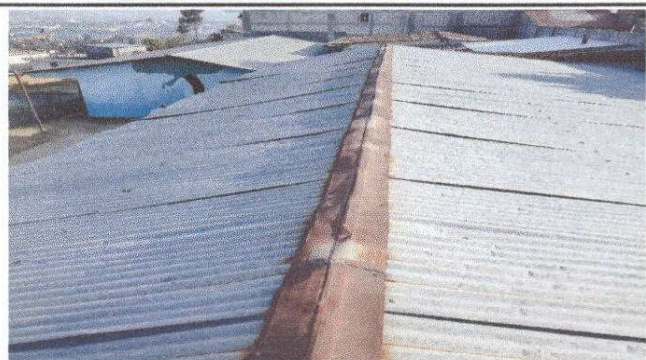
Foto 1: SUSTITUCION DE LAMINA POR LAMINA TROQUELADA, SUSTITUCION DE ESTRUCTURA DE SOPORTE DE MADERA A METAL
