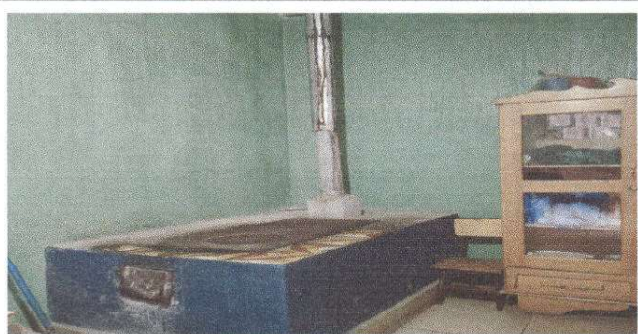
Foto 5: SUSTITUCION DE CERAMICA SOBRE Y A LOS LADOS DE PLANCHA RURAL, SUSTITUCION DE CHIMINEA A CONCRETO
