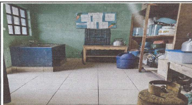
Foto 4: REMOZAMIENTO DE VENTANA, PILA, INSTALACION DE DESAYUNADOR CON CERAMICA Y PUERTA, SUSTITUCION DE SISTEMA ELECTRICO
