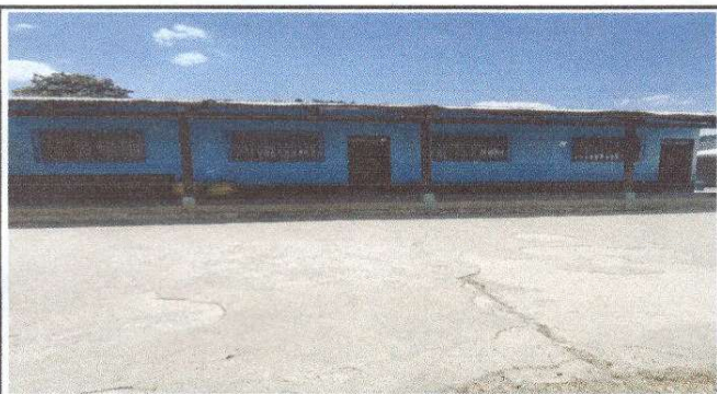
Foto 3: MANTENIMIENTO A ESTRUCTURA DE METAL DE VENTANA
