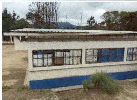
Foto 2: Sustitución de canales de PVC y bajadas de agua
