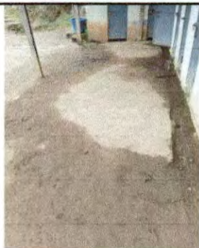
Foto1: Sustitución de torta de cemento por adoquín
