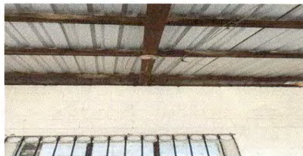
Foto 4: Sustitución de cableado electrico y plafoneras.
