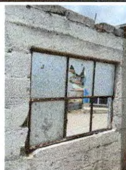
Foto 6: Reparación de muro perimetral
