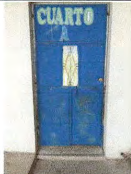
Foto 2: Mantenimiento de puertas
