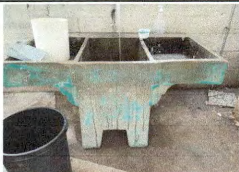
Foto 3: Reparación red de drenaje de lavaderos.
