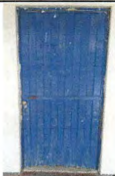
Foto 3: Sustitución de puerta de metal.
