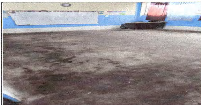
Foto 5: Sustitución de piso de torta de concreto en mal estado a piso cerámico de aula.
