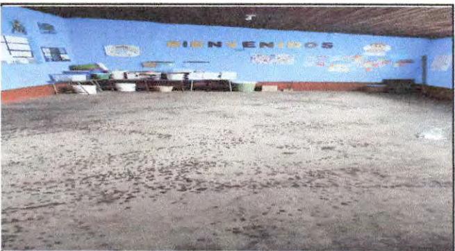
Foto 4: Sustitución de piso de torta de concreto en mal estado a piso cerámico de aula.
