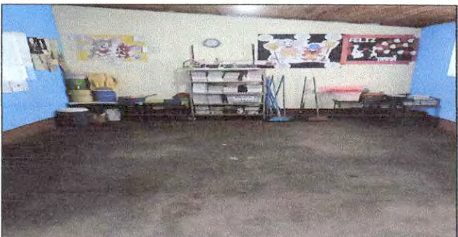
Foto 6: Sustitución de piso de torta de concreto en mal estado a piso cerámico de aula.
