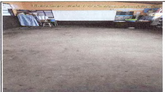
Foto 3: Sustitución de piso de torta de concreto en mal estado a piso cerámico de aula.
