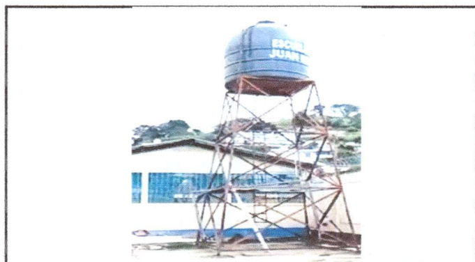
Foto 3: Sustitución de estructura metálica deteriorada del deposito de agua por estructura metálica.
