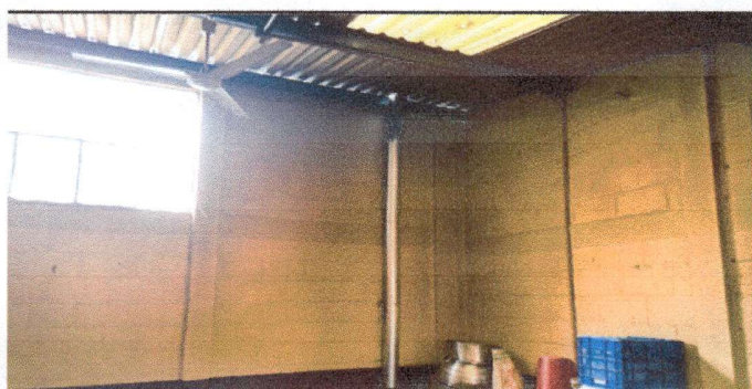
Foto 6: Sustitución de chimenea de metal por dos extractor de galvanizado y lamina de acero inoxidable de 2.30 x2.30
