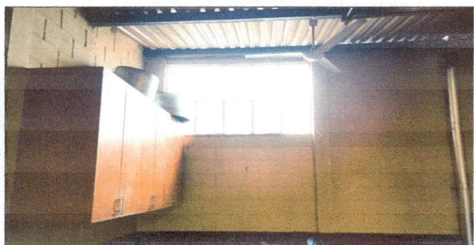
Foto 5: Area donde sustituirá la ventana de metal por una de UPVC de 1.20 x 2.50 tipo corrediza
