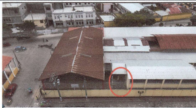
Foto 2: Area donde se colocara el deposito de agua.
