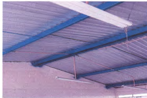
Foto 4: Reparación de sistema eléctrico y sustrución de lámpara tipo LED
