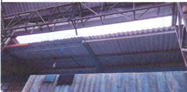
Foto 7: Instalación de canal aluzinc con bajada.
