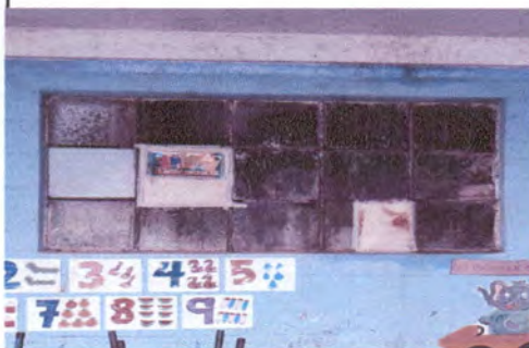
Foto 8: Sustitución de vidrios.
