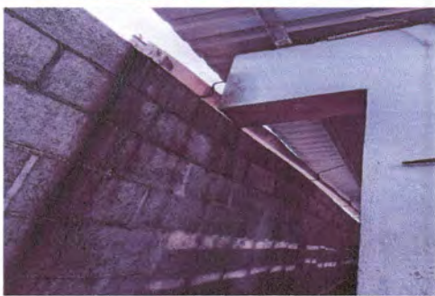
Foto 5: Cambio de canal por canal aluzinc con sus bajadas.
