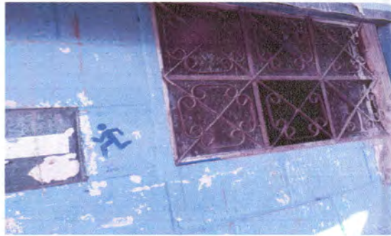
Foto 3: Sustrución de ventanas
