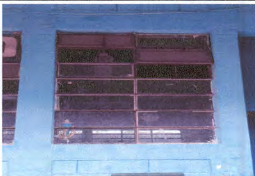
Foto 9: Sustitución de vidrios.
