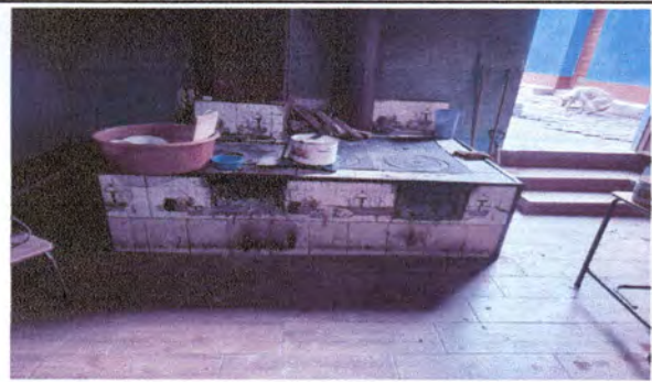
Foto 2: Sustrución de 2 planchas incluye chimenea
