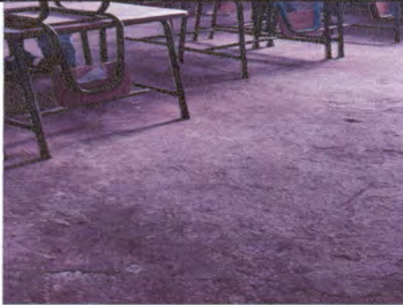
Foto 1: Sustrución de piso de torta de cemento por cerámico
