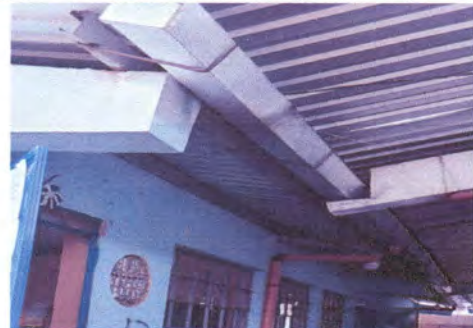
Foto 6: Reparación de canal de agua he instalación de bajada.
