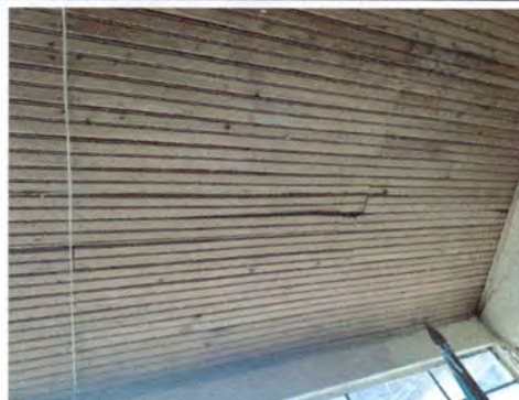
Foto 8: sustitucion de cielo falso en direccion con una medida de 10 M2
