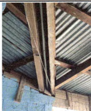
Foto 5: sustitucion de canal de 5 ml en direccion
