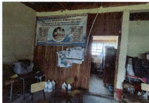
Foto 2: sustitucion de pared machimbre por tablayeso en direccion con una medida de 8 m2
