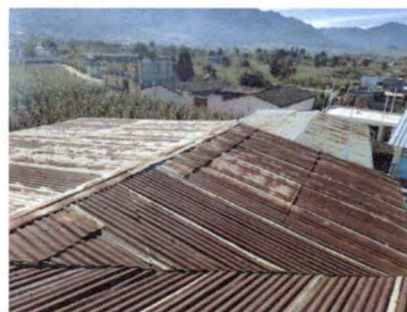
Foto 4: sustitucion de cubierta de lamina y estructura en direccion con una medida de 75 m2
