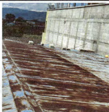
Foto 9: SUSTITUCION DE CUBIERTA DE LAMINA EN AULAS CON UNA MEDIDA DE 32 M2
