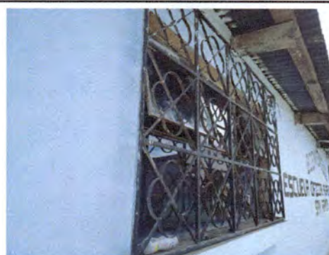
Foto 10: SUSTITUCION DE VENTANA EN AULA DE 0.80 *1.5 MT
