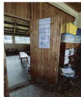
Foto 6: sustitucion de una puerta en direccion
