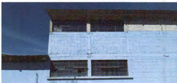
Foto 11: INSTALACION DE 2 BALCON DE 1*2.5 MT C/U
