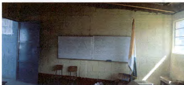
Foto1: Repellado y blanqueado de pared en direccion con una medida de 75 m2
