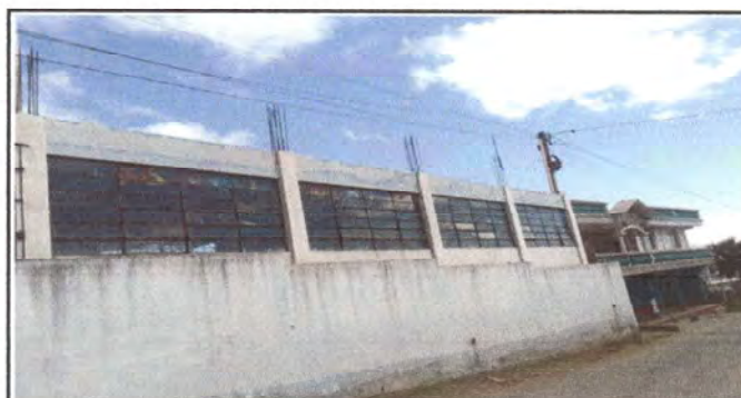
Foto 4: Instalación de balcones de metal en aulas 1 y 2 parte trasera de las mismas
