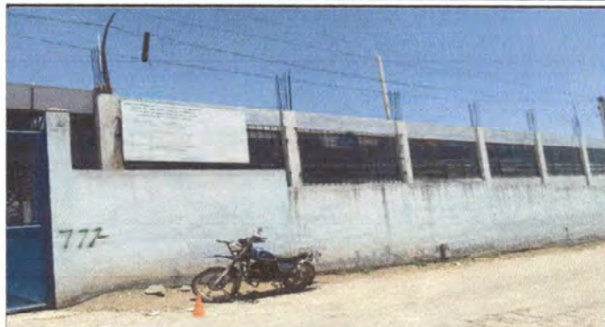
Foto 2: Pintura en muro exterior parte trasera del establecimiento.
