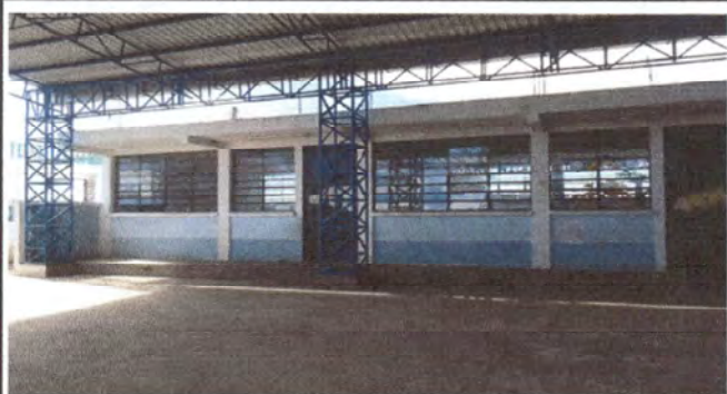
Foto 1: Instalación de balcones de metal en las aulas 1 y 2 parte frontal y Pintura en las mismas interior y exterior
