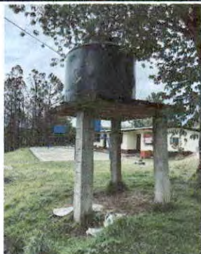
Foto 1: Suministro e instalación de depósito de agua y reforzamiento de base de depósito con acabado rustico
