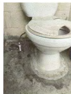
Foto 4: suministro y e instalacion de tazas sanitarias pequeñas marca FATIMA
