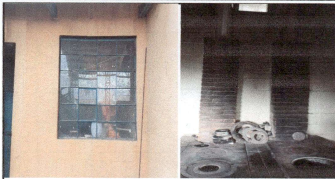
Foto 2: Cambio de chimenea y ventana en la cocina
