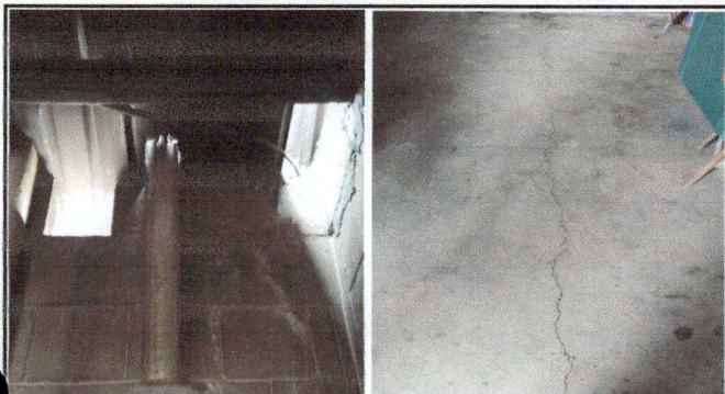
Foto1: Cambio de lamina y piso de la cocina
