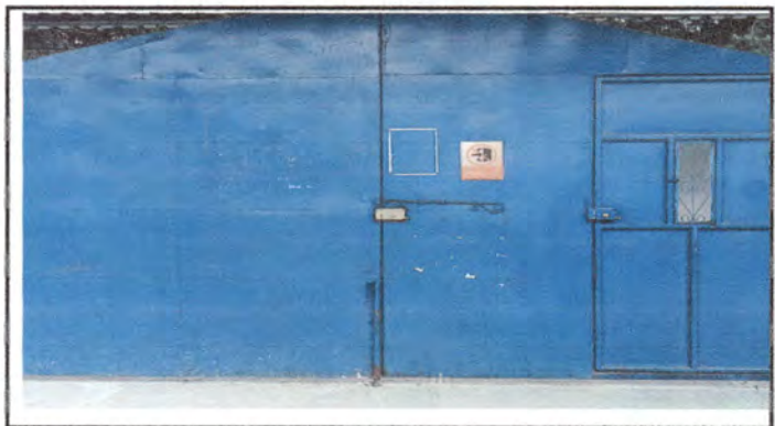
Foto 4: Mantenimiento a portones
