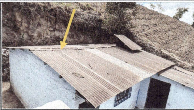
Foto 2: SUSTITUCIÓN DE COPOTE TROQUELADA
