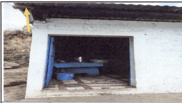
Foto 4: SUSTITUCIÓN ESTRUCTURA SOPORTE DE MADERA, POR METAL
