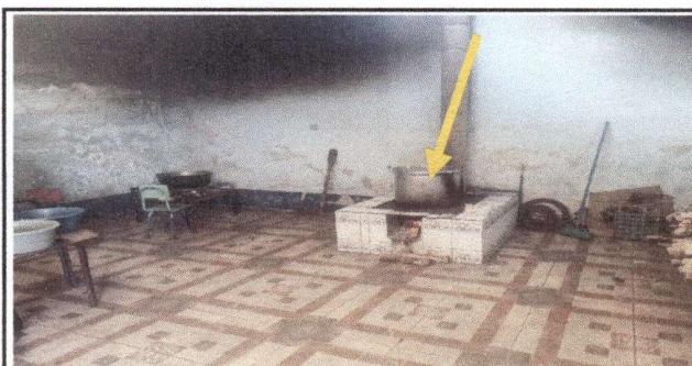
Foto 6: SUSTITUCIÓN DE PLANCHA
