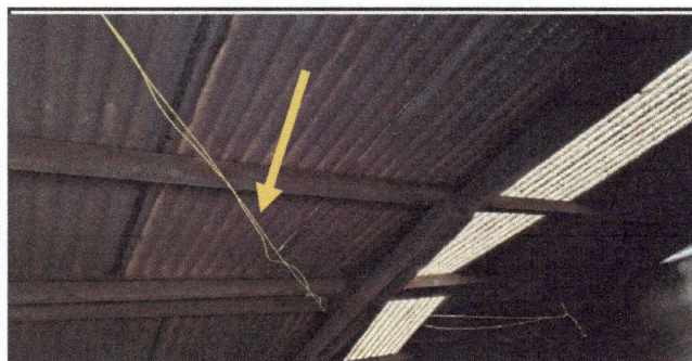
Foto 5: REPARACIÓN CABLEADO EELÉCTRICO
