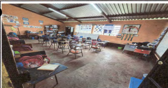
Foto 11: Aula de Tercero, con piso de cemento liquido
