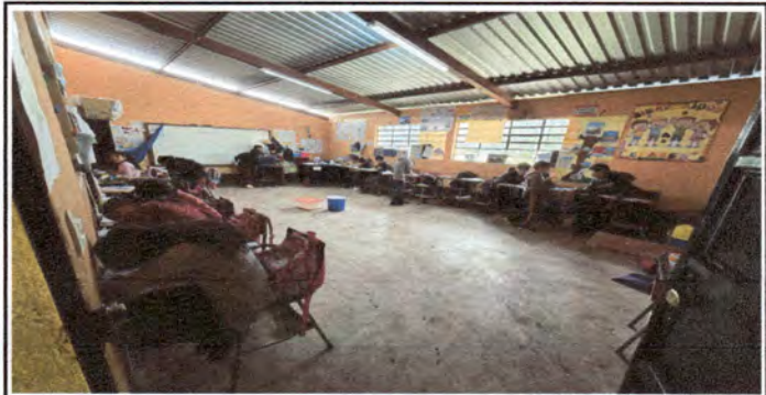
Foto 12: Aula de quinto, con piso de cemento liquido
