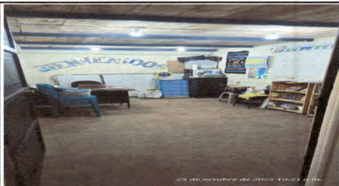
Foto13: Dirección, con piso de cemento liquido
