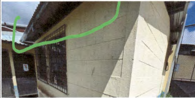
Foto19: Aulas donde necesitamos colocar Block
