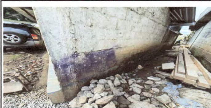
Foto 18: Aula de Cuarto B, espacio de pared para proteger por filtración
