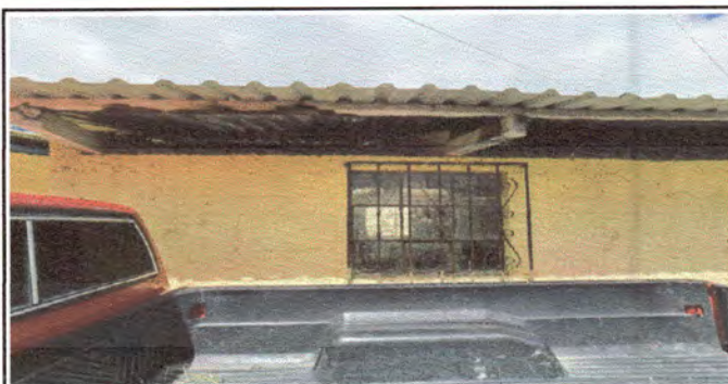
Foto 5: Parte de atrás del aulas, techo portante de madera en malas condiciones
