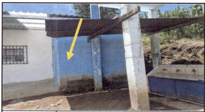
Foto 6: SUSTITUCIÓN DE PLANCHA
