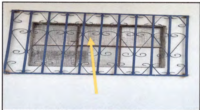
Foto 4: SUSTITUCIÓN ESTRUCTURA DE VENTANA
