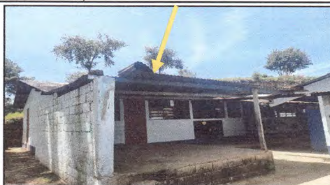
Foto 8: CUBIERTA DE LÁMINA Y ESTRUCTURA DE TECHO (ESENARIO)
