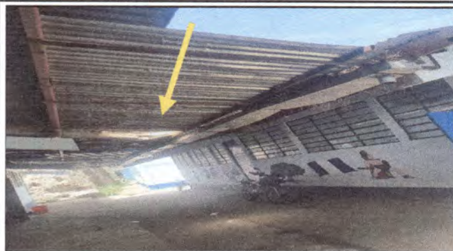
Foto 7: CUBIERTA DE LÁMINA Y ESTRUCTURA DE TECHO (PASILLO)
