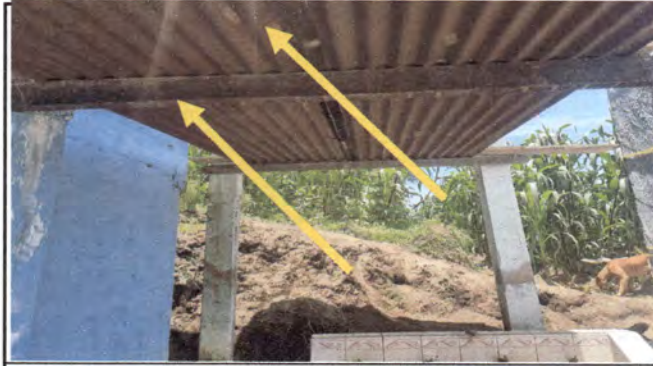
Foto 1: CUBIERTA DE LÁMINA Y ESTRUCTURA DE TECHO (LAVA MANO)
