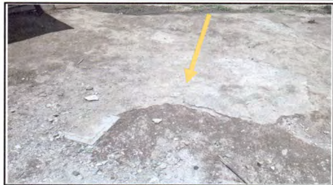
Foto 2: SUSTITUCIÓN DE PISO
