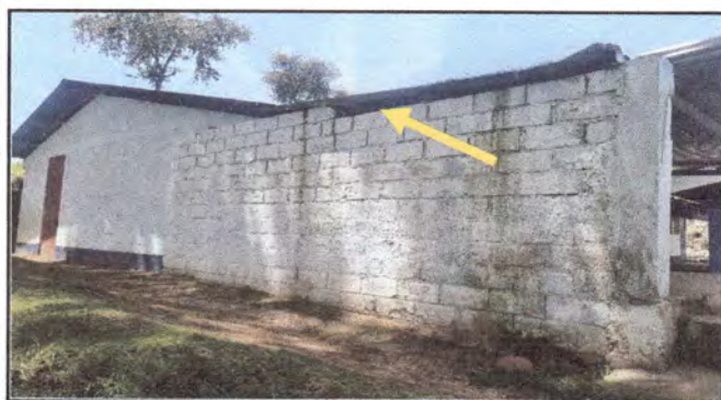
Foto 9: AMPLIACIÓN PARED DE ESENARIO (ALTURA)
