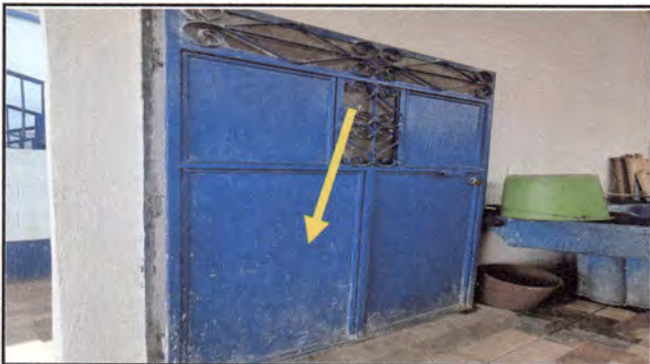
Foto 3: MANTENIMIENTO DE PUERTA DE METAL
