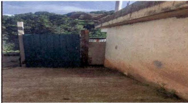
Foto 7: PANTAR PAREDES EXTERIORES Y UTILIZACION DE PASAMANOS.
