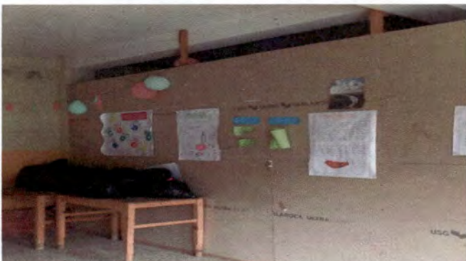
Foto 3: REMODELACIÓN DE DIVISIONES EN DOS AULAS.
