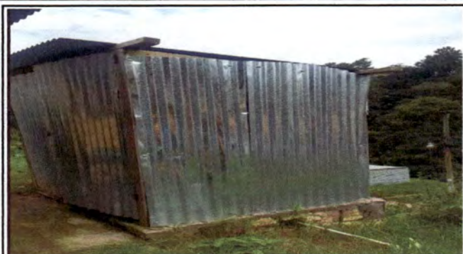
Foto1: REMODELACION DE LAS PAREDES Y PUERTAS DE LOS SERVICIOS SANITARIOS.
