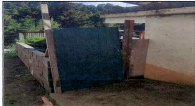
Foto 8: REMODELACION DEL MURO PERIMETRAL Y PUERTA DEL NUFED.
