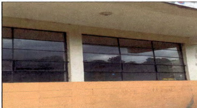
Foto 2: REMODELACION DE VENTANAS Y BALCONES.
