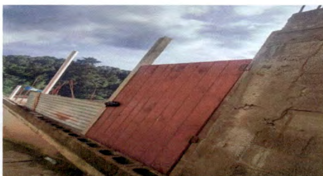
Foto 6: SUSTITUCION DE LAS LAMINAS POR BARANDAS Y PUERTAS COMO MEDIDA DE PREVENCIÓN EN EL SEGUNDO NIVEL DEL ESTABLECIMIENTO.
