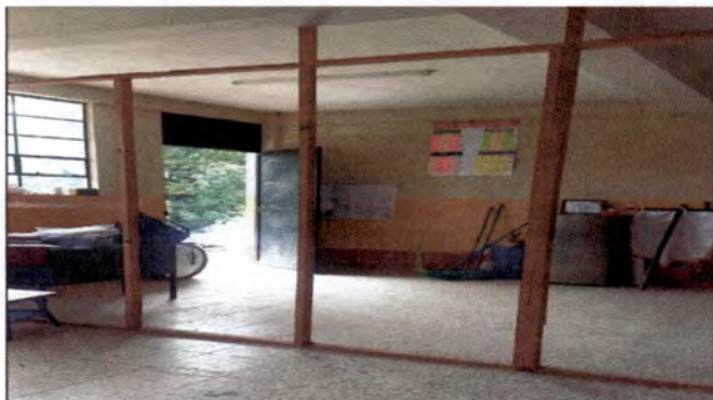
Foto 4: DIVISIONES DE AULAS.
