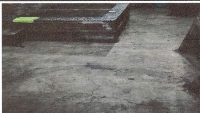
Foto 3: Piso de cocina
