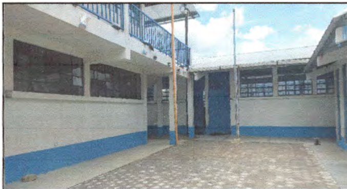
Foto 4: Colocación de balcones en las ventanas de las aulas de primero, segundo y tercero básico ubicados en el primer nivel. (aulas 2,3 y 4 después de la dirección)
