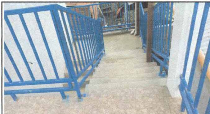
Foto 2: Cambio de pisos quebrados en la entrada del segundo nivel y colocación de pisos en las gradas del primer y segundo nivel.
