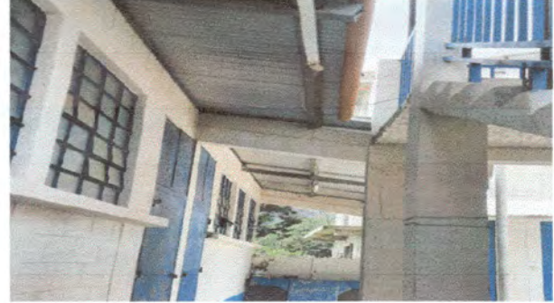
08. Reparacion de sistema electrico y colocacion de focos led.
