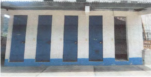
07. Colocacion de puerta de metal para baño de varones.
