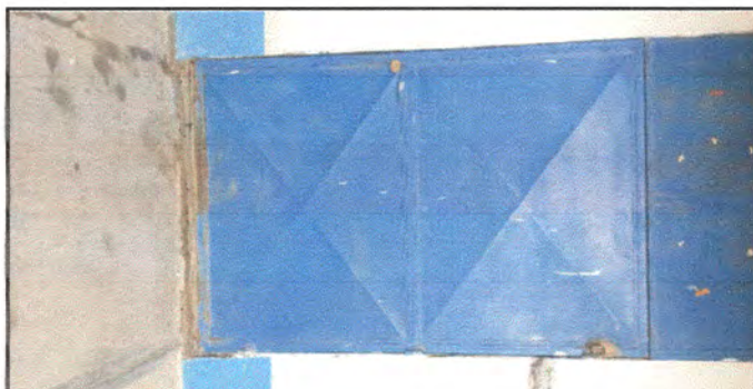
Foto 6: Sustitución de puerta de metal en el aula número 4, que ocupa primero básico. (por abolladuras, mal estado de la cerradura y oxidación de la misma)
