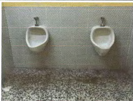
Sustitucion de Mingitorios
