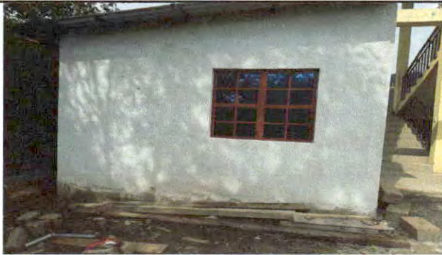
Instalacion de balcones en cocina
