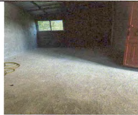
Instalacion de piso ceramico en cocina
