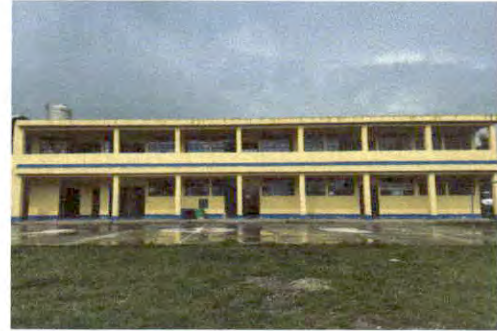
Instalacion de balcones en 5 aulas
