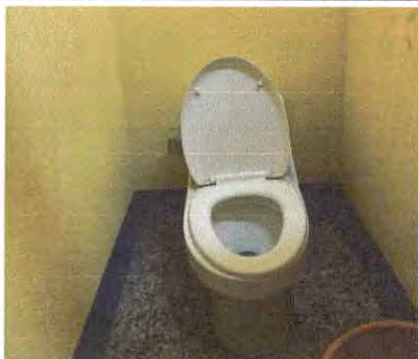
Sustitucion de 4 inodoros
