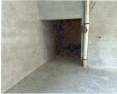
Instalacion de puerta en cocina.
