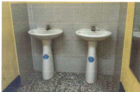
Sustitucion de 4 lavamanos
