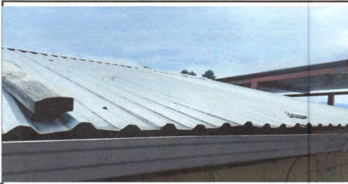
Foto1: Cubierta de lámina: Sustitución de Láminas troqueladas en mal estado por láminas troqueladas calibre 26, en el laboratorio de computación y cocina. instalación de canal galvanizado de 10cm de fondo por 20 cm de ancho, con una longitud de 9,5mts, sujetado con bases metálicas, bajada pluvial con tubo de 3
