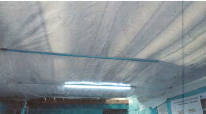
Foto 3:cambio de estructura de madera de tabanco, vigas y tablas por estructura de metal con base a vigas galvanizadas de 4x2 pulgadas chapa 16, distanciados a 2 pies, instalación de plywood de 3/4 de pulgadas para tabanco, sujetados con tornillos pulser.
