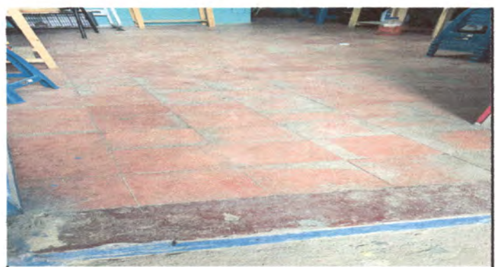
Foto 4: instalación de piso cerámico a cocina y laboratorio de computación. 35 mts 2
