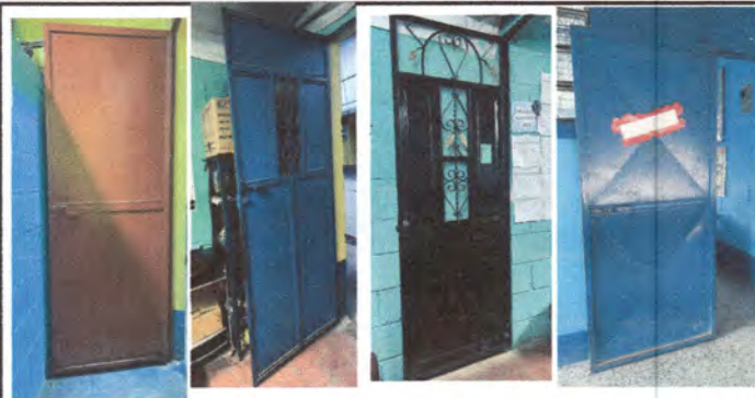
Foto 9: Fabricación e instalación de puertas metálicas formadas con tubo base de 1 pulgada y lamina de 1mm de espesor, diseño liso abatible, con las dimensiones a 1mts de ancho x 2.10mts de alto, protegido con anticorrosivo color negro. 2 puertas que se utilizaran en el baño contarán con las siguientes medidas 0.60 mts de ancho x 1.50 de alto
