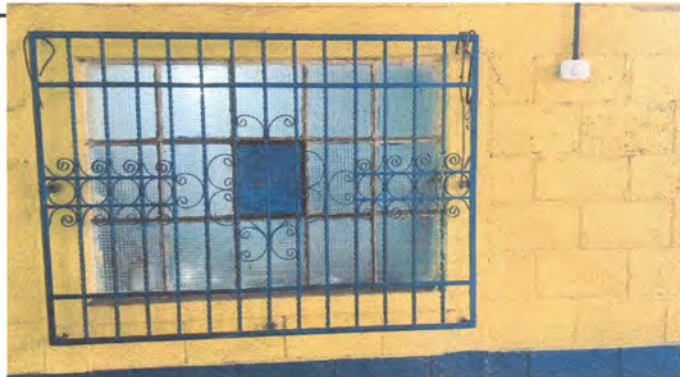
Foto 10: Fabricación e instalación de balcones metálicos formados con hierro angular de \frac{3}{4} y hierro entorchado de \frac{1}{2} , anclado con tornillos hiltin, con dimensiones a
