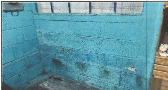
Foto 7: Mano de obra de aplicación de pintura bloqueador de agua de sherwin willams a dos manos. Esto se realizarara en la parte interna de la cocina y el laboratorio de computación.
