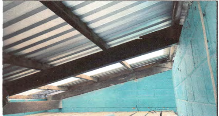
Foto 2: cambio de estructura de techo de madera por estrucuta metálica formado con tubo de 4x4 galvanizado chapa 16, costaneras de 4x2 mm galvanizada, sujetado con tonillos hiltin y soldadura electrica
