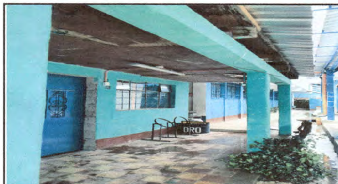
Foto 4: Cambio de la estructura de techo de madera por metal. Cambio de 1 ventana de metal por aluminio blanco y colocación de 1 balcon, sustitución de 12m 2 de piso en mal estado y reemplazo de ducto electrico.
