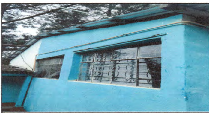
Foto 5: Cambio de 2 ventanas de metal en mal estado por aluminio blanco y colocación de 2 balcones.
