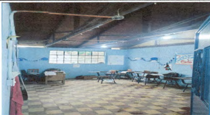
Foto 1: Cambio de la estructura de techo de madera por metal. Cambio de 1 ventana y colocación de 1 balcon, sustitución de 12m 2 piso en mal estado.
