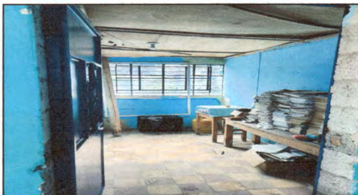
Foto 3: Cambio de la estructura de techo de madera por metal, cambio de 9m 2 piso en mal estado y sustitución de ducto eléctrico y sus accesorios, cambio de plafonera por 1 lampara de tubos led.
