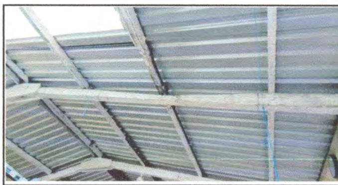
Foto 12: Sustitución de una lamina troquelada de metal de sobre el aula, a cambio de mal estado.
