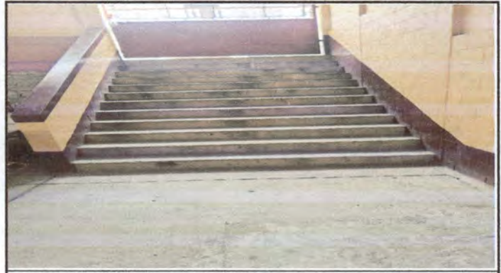
Foto 14: Instalación de piso antilicante en las gradas entrada principal a cambio de la torta de cemento.
