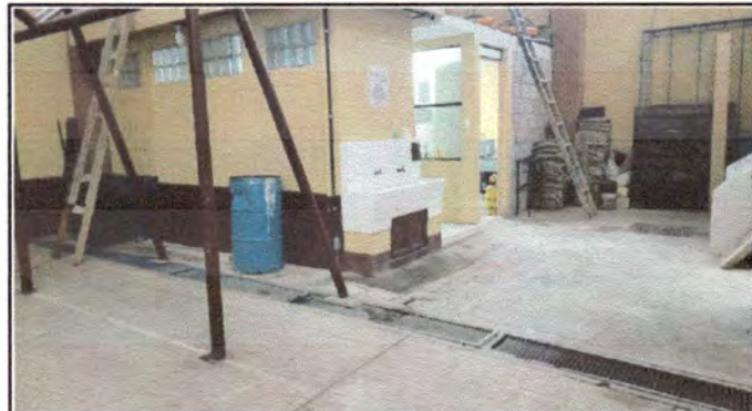
Foto 4: losa de patio e instalacion de piso Anda Lucia en patio.
