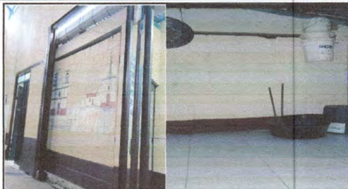
Foto 7: Remodelación de bodega hecha de block, Con fisuras levantado y sellado con columnas.
