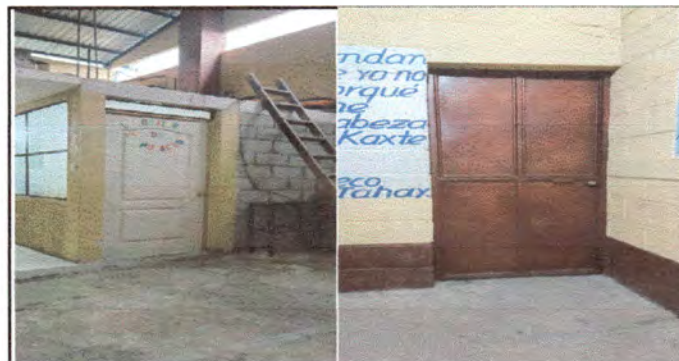
Foto 6: Sustitución de dos puertas a metal color madera, a cambio de puerta prefabricada y puerta en mal estado de metal.
