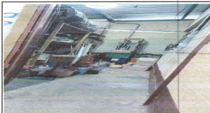
Foto 9: Pintada dentro de la bodega la parte interior de la misma.
