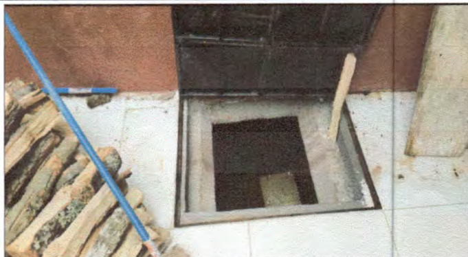
Foto1: Desvaciado de la fosa septica, y rellenado con celecto tapado y sellado.
