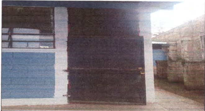
Foto 10: Mantenimiento a puertas
