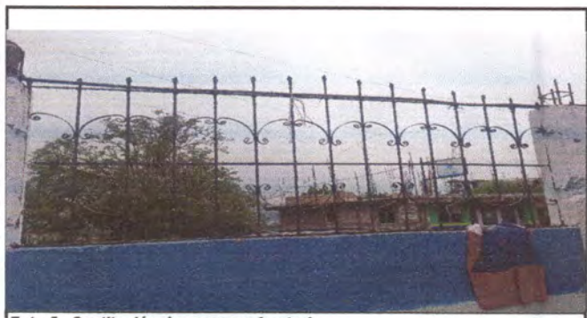
Foto 5: Sustitución de cerco perimetral
