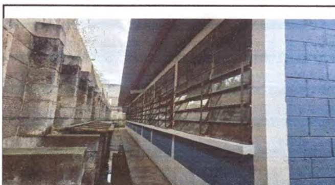
Foto 4: Instalación de balcones en ventanas
