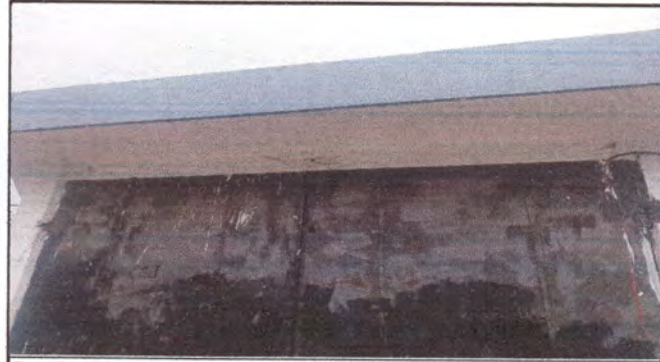
Foto 8: Mantenimiento de porton
