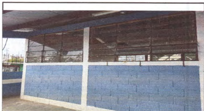
Foto 3: Instalación de balcones en ventanas
