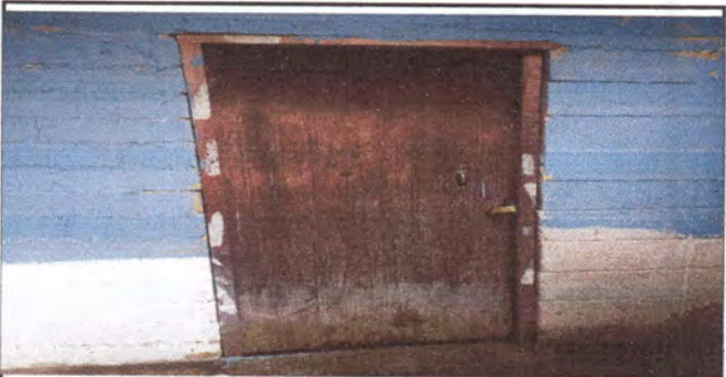
Foto 11: Sustitución de puerta
