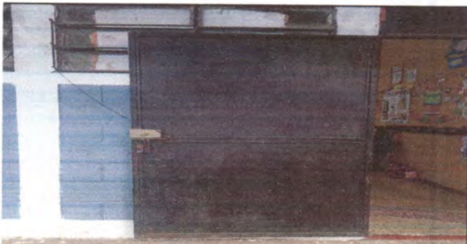
Foto 9: Mantenimiento a puertas
