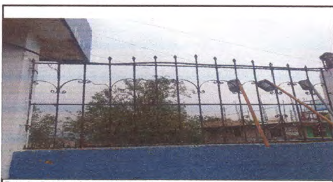
Foto 6: Sustitución de cerco perimetral
