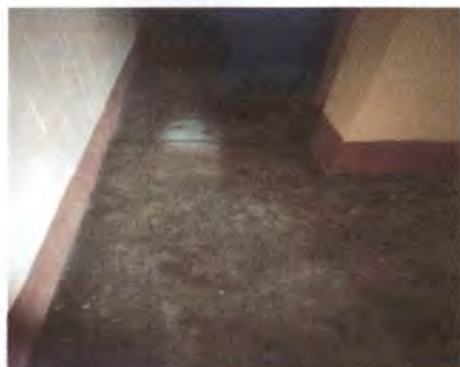
Foto 19: PISO DE TORTA DE CEMENTO LISO POR PISO DUELA
