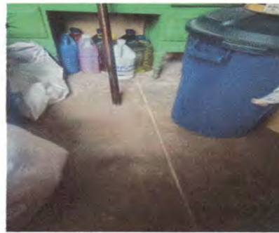
Foto 18: PISO DE TORTA DE CEMENTO POR PISO DUELA
