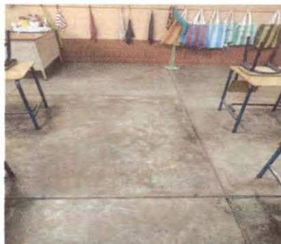
Foto 8: PISO DE TORTA DE CEMENTO POR PISO DUELA
