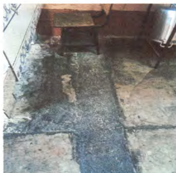
Foto 15: PISO DE CEMENTO LISO POR PISO DUELA
