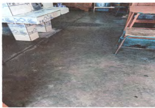
Foto 14: PISO DE TORTA DE CEMENTO POR PISO DUELA
