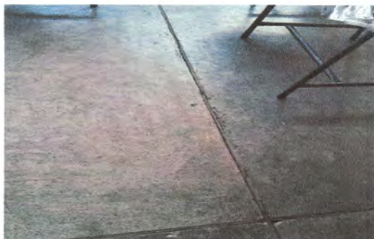
Foto 11: PISO DE TORTA DE CEMENTO LISO POR PISO DUELA
