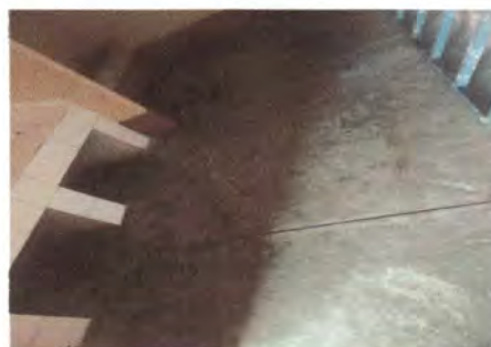
Foto 20: PISO DE TORTA DE CEMENTO POR PISO DUELA
