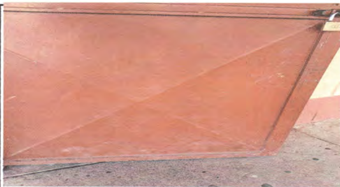
Foto 6: PUERTAS QUE SE VA A CORTAR Y PINTAR
