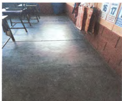
Foto 9: PISO DE CEMENTO LISO POR PISO DUELA
