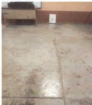
Foto 13: PISO DE TORTA DE CEMENTO LISO POR PISO DUELA
