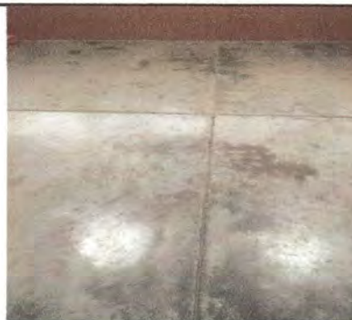
Foto 12: PISO DE TORTA DE CEMENTO POR PISO DUELA
