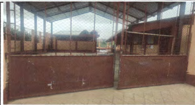
Foto 2: PUERTA PRINCIPAL, ESTADO ACTUAL.
