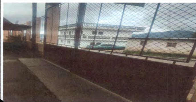
Foto 1: MALLA, ESTADO ACTUAL
