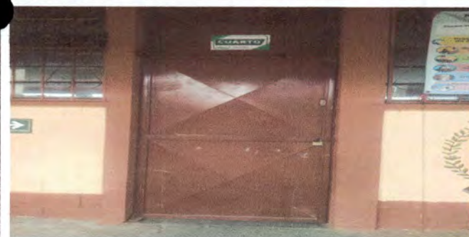
Foto 5: PUERTAS QUE SE VA A CORTAR
