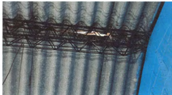
Foto 8: Remozamineto de techo duralita a techo troquelada.
