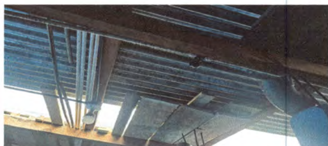
Foto 9: Remozamineto de techo zinc a troquelada area de sanitarios.
