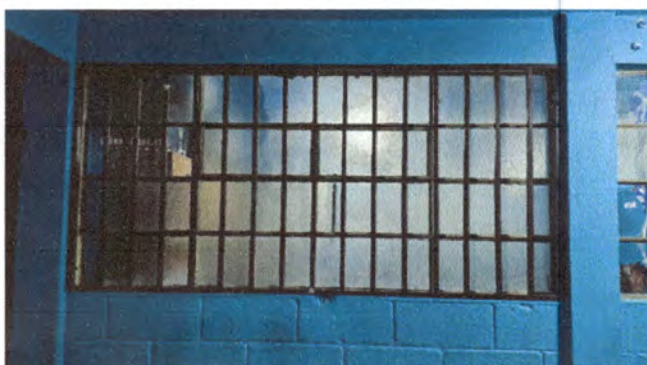
Foto 3: Instalacion de ventana y cambio de balcón aula No. 2
