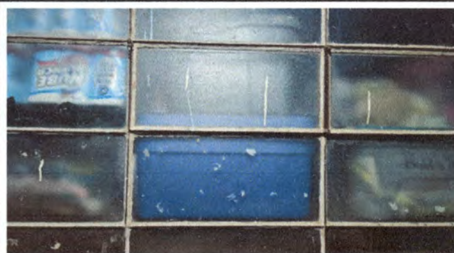
Foto 2: Remozamiento de ventana de metal por PVC corredizo
