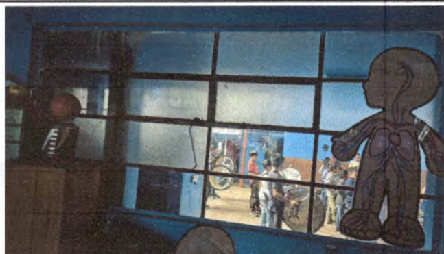
Foto1: Renozamineto de ventana de metal por PVC Corridizo.
