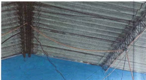
Foto 7: Cambio de techo.
