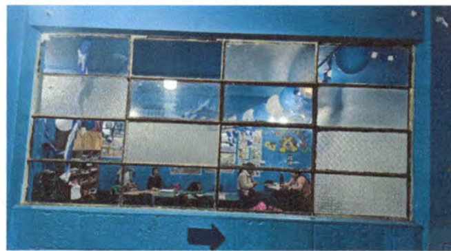
Foto 4: Instalación de balcón, aula No. 2
