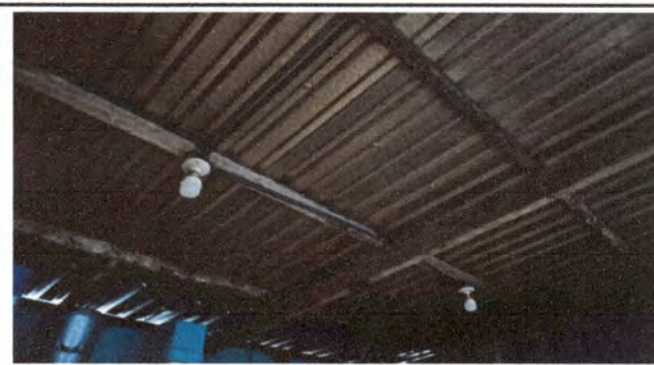
Foto 6: Remozamineto de techo de cocina.
