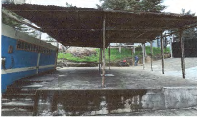
Foto 1: Estructura de madera y cubierta de lámina
