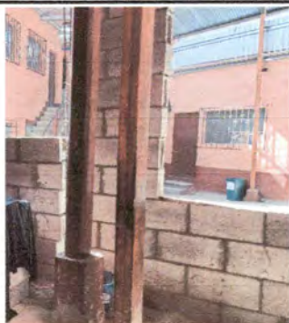
Foto 3: Instalación de repisas de tablayeso en pilares en cocina
