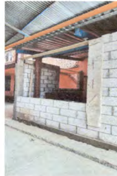
Foto 2: Instalación de persiana metálica en cocina
