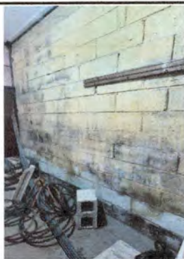
Foto 3: Cernido de paredes en bodega
