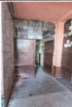
Foto 1: Mantenimiento de puerta principal y balcones en bodega
