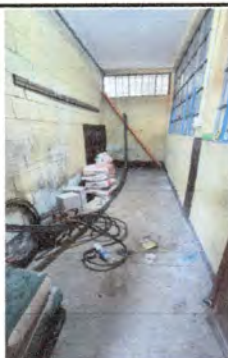
Foto 5: Instalación de piso cerámico en bodega
