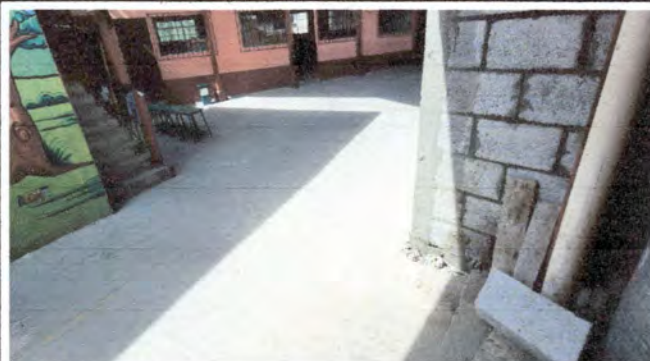
Foto 2: introducción de drenaje en cocina
