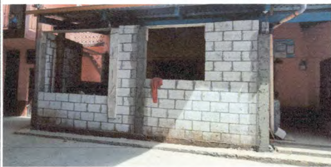
Foto 5: pintura en paredes de cocina
