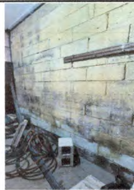
Foto 4: Pintura de paredes en bodega
