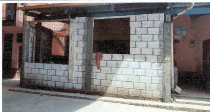
Foto1: repello y cernido vertical en paredes en cocina
