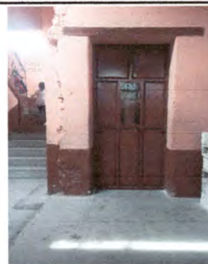
Foto 4: Mantenimiento de puerta metálica en cocina
