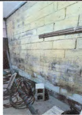
Foto 2: Repello en paredes en bodega
