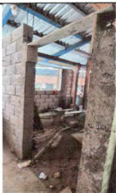
Foto 3: Instalación de puerta de metal en cocina
