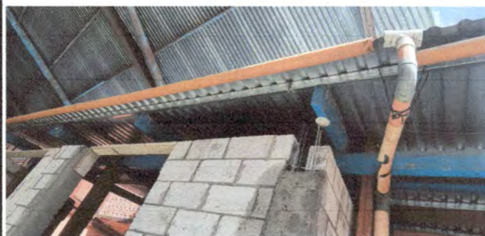
Foto 4: Sustitución de canal de alto caudal en techo de cocina
