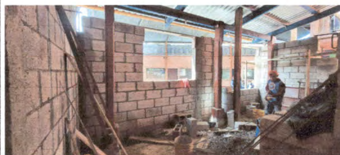
Foto 4: Instalación de energía eléctrica en cocina
