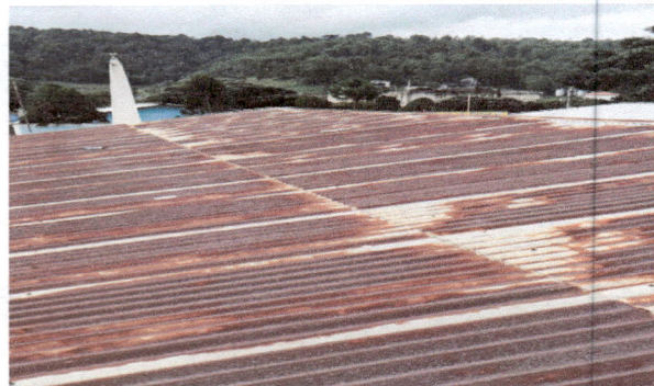
Foto 1: sustitucion de lamina acanalada
