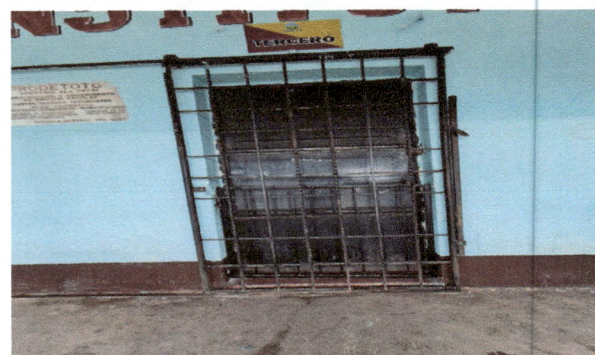
Foto 3: sustitucion de rejas para puertas
