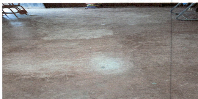
Foto 5: sustitucion de piso
