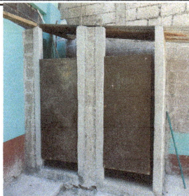
Foto 2: Sustrución de puertas en baños
