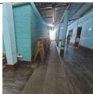
Foto 4: Sustrución de piso en gradas del modulo 1
