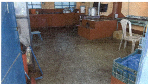
Foto 5: Sustrución de piso en cosina
