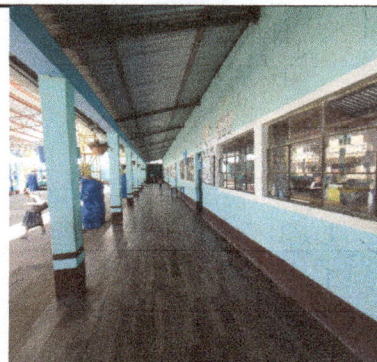
Foto 6: Mantenimiento de pintura en muros interiores
