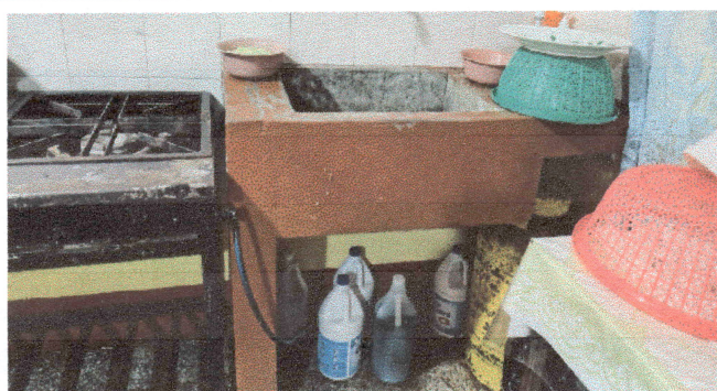
Foto 3: REMOZAMIENTO DE LAVATRASTOS DIMECIONES 1.20X2.00 MTS PARA COCINA.
