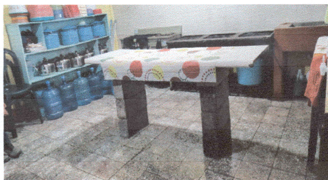
Foto 2: REPARACION DE MESA PARA COCINA EN CONCRETO INCLUYE PUERTA DE 1.00X1.30 MTS
