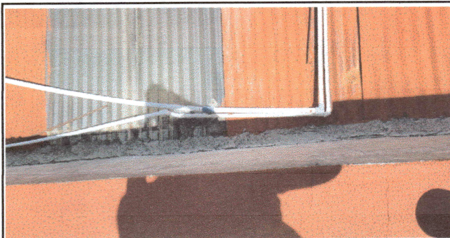
Foto 5: REMOZAMIENTO DE PARED EXTERIOR DE BODEGA DE ALIMENTOS
