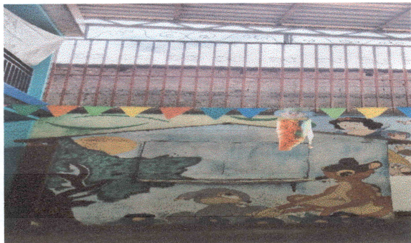
Foto1: REMOZAMIENTO DE BODEGA PARA EDUCACION FISICA
