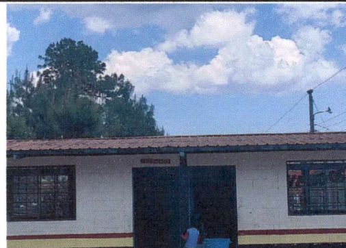
Foto 4: Vista previa del la cubierta del techo, se sustituirá con nuevo techo.
