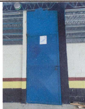
Foto 2: Vista previa puertas, se les dará mantenimiento y se instalarán chapas.
