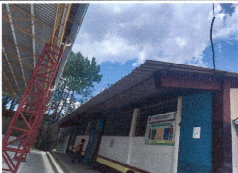
Foto1: Vista previa del techo sin caída de agua, se instalará la caída de agua pluvial
