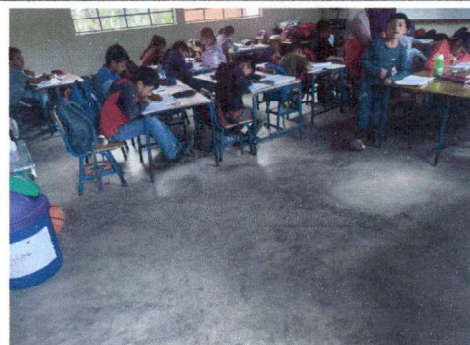
Foto 6: Vista previa piso de aula, se sustituirá por piso cerámico.
