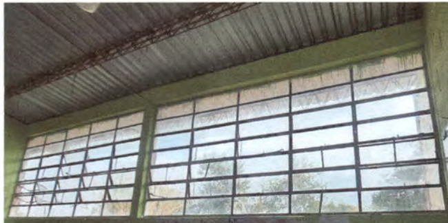
Foto1: Estado actual de las ventanas
