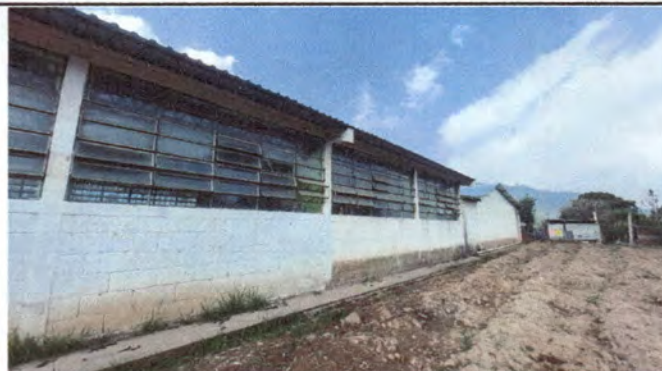
Foto 2: Ventanas donde se colocan los balcones.
