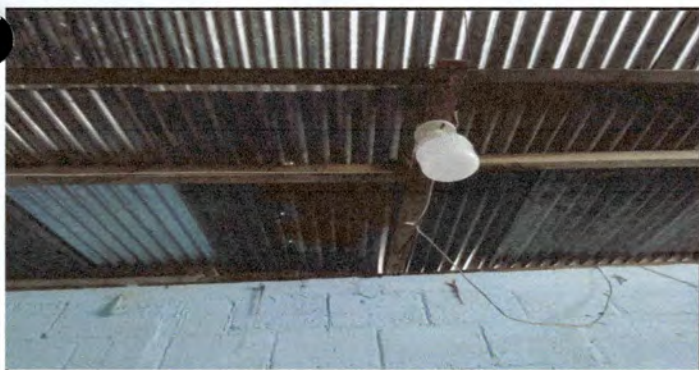
Foto 5: Cambio de estructura de madera y lamina ondulada por estructura de metal con costaneras 4*2 plg, galvanizado y lámina troquelada de Aluzinc calibre 26, sujetado con tornillos autoperforables.
