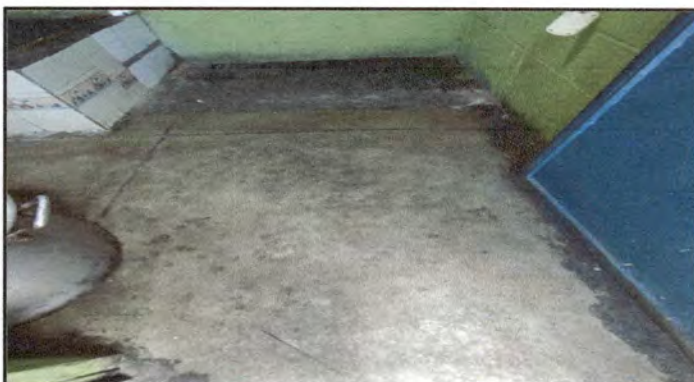
Foto 4: Instalación y suministro de 14 metros cuadrados de piso cerámico, pegado y nivelado con pegamix verde a cocina.
