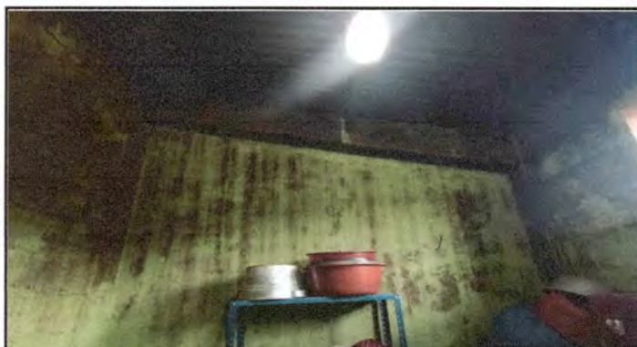
Foto 15: Aplicación de pintura marca Sherwin Williams a paredes solidas de cocina con un total de 91 metros cuadrados.
