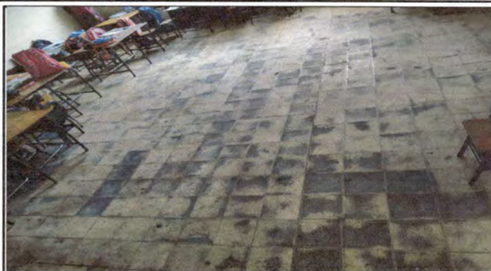
Foto 2: Instalación y suministro de 39 metros cuadrados de piso cerámico, pegado y nivelado con pegamix verde a aula 2.
