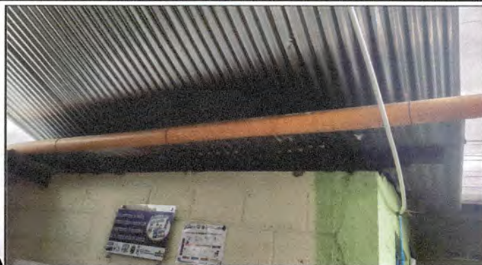
Foto 13: Fabricación e instalación de 7 metros lineales de canal galvanizado de Aluzinc, sellado con sika-flex, bajada pluvial y estructura para soporte.
