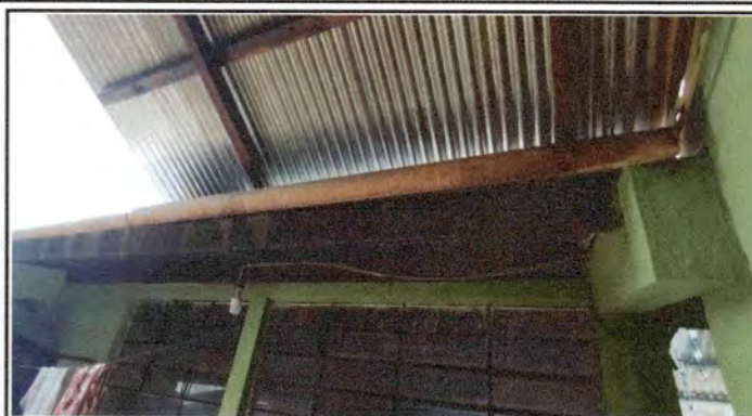
Foto 14: Fabricación e instalación de 9 metros lineales de canal galvanizado de Aluzinc, sellado con sika-flex, bajada pluvial y estructura para soporte.
