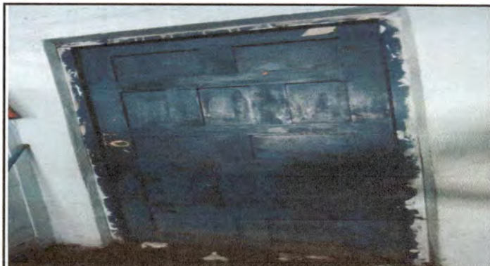
Foto 10: Fabricación e instalación de puerta metálica tipo corredizo, diseño estructural liso, con tubo base de 1 pulgada y lámina lisa de 1mm, de 91cm de ancho y 211cm de alto, protegido con anticorrosivo color azul.
