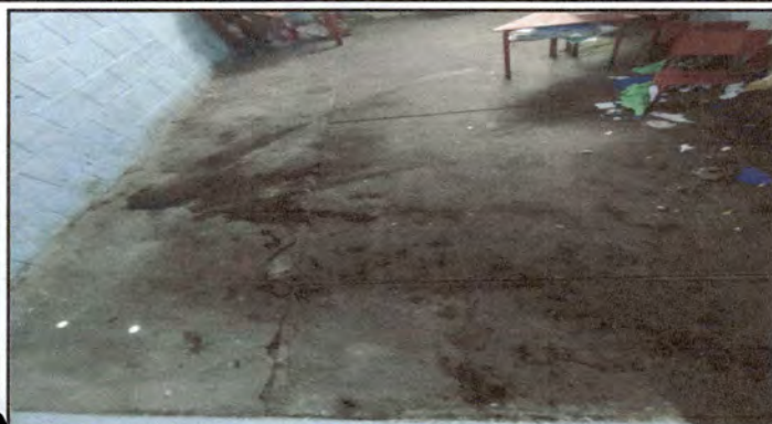
Foto 1: Instalación y suministro de 19 metros cuadrados de piso cerámico, pegado y nivelado con pegamix verde a aula 1.
