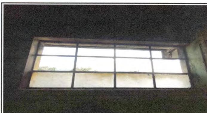
Foto 16: Fabricación e instalación de mosquitero a ventana metálica de 1.5mts x 0.50 mts a cocina.
