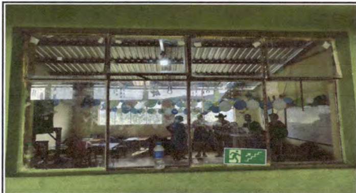
Foto 9: Fabricación e instalación de ventana de Upvc en vento, color blanco, vidrio transparente de dimensiones a 104cm x 180cm.
