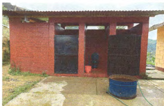
Foto 5: Sustitución de 3 servicios sanitarios y prorización de un deposito de agua, con base de metal.
