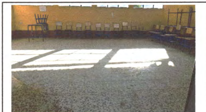
Foto 9: sustitución de piso en el aula de Segundo Primaria
