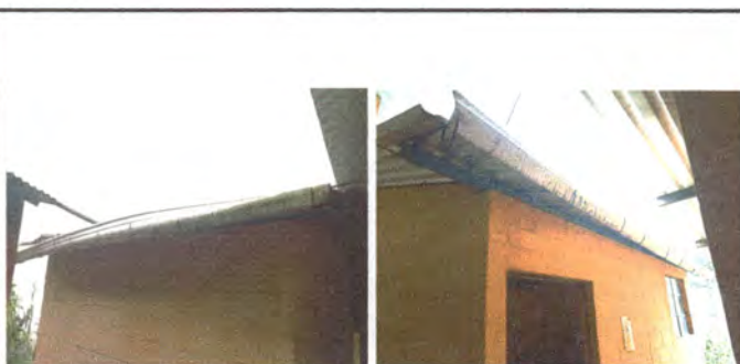
Foto 12: Sustrución de canales delante y detrás del aula de Quinto Primaria.
