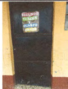
Foto 16: Sustitución de puerta en el aula de Segundo Primaria.
