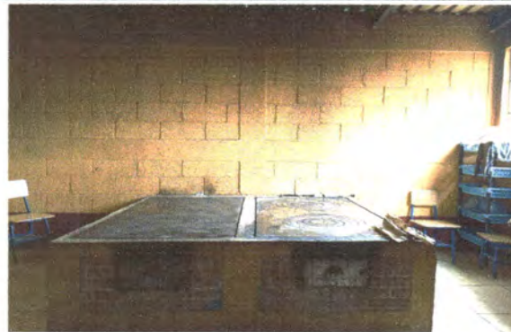
Foto 2: Sustitución de 2 planchas (completas).
