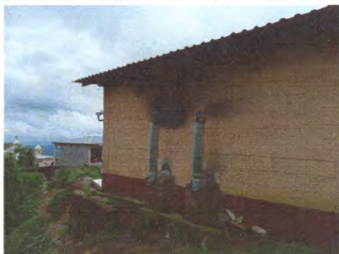
Foto1: Cambio de chimeneas, colocación dentro de la cocina.
