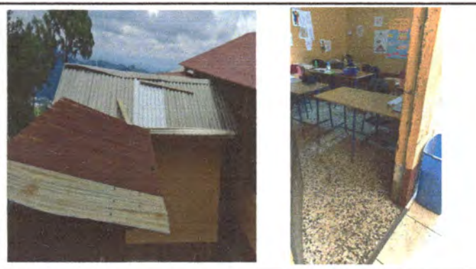
Foto 8: Sustrución de techo y piso en el aula de Quinto Primaria.
