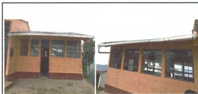
Foto 11: Sustrución de canales delante y detrás del aula de Segundo Primaria.
