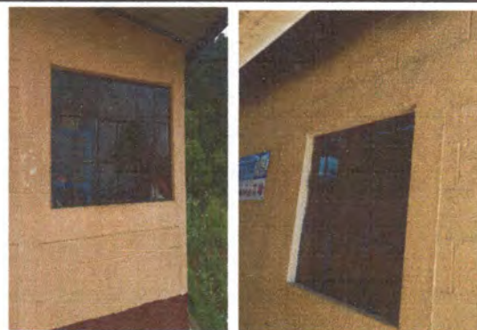
Foto 4: Sustitución de 2 ventanas en la cocina.
