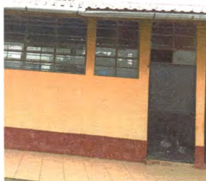
Foto 14: Sustitución de puerta en el aula de Primero Primaria.
