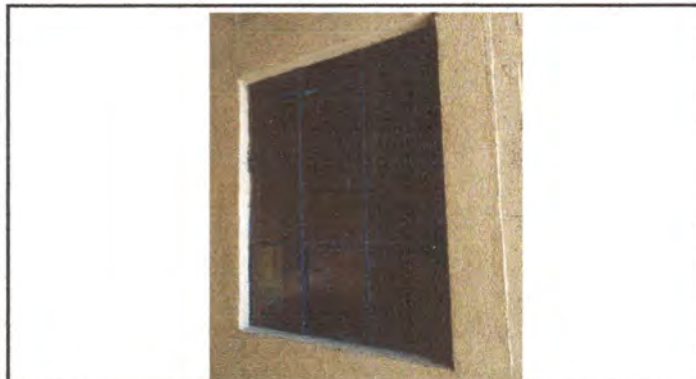
Foto 7: Sustrución de ventana en el aula de Quinto Primaria.
