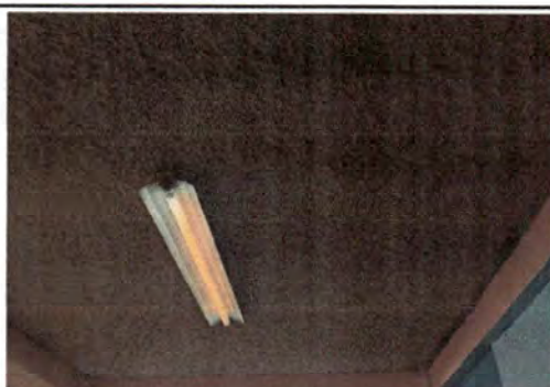
Foto 5: SUSTITUCION DE LAMPARAS GASNEON A TIPO LED
