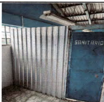
Foto 5: Sustitucion de lamina por pared de tablayeso
