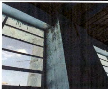
Foto 2: Sellado de grietas y fisuras en muros
