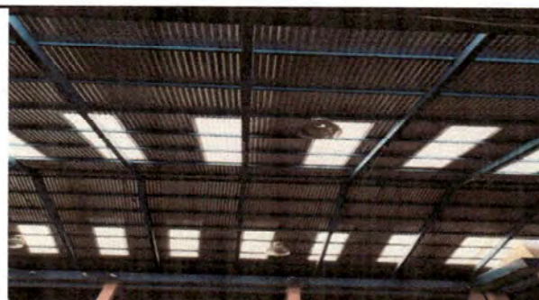
Foto 6: REPARACION DE LAMPAPARAS DE MERCURIO
