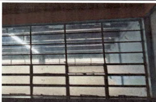
Foto 3: Cambio de vidrios quebrados
