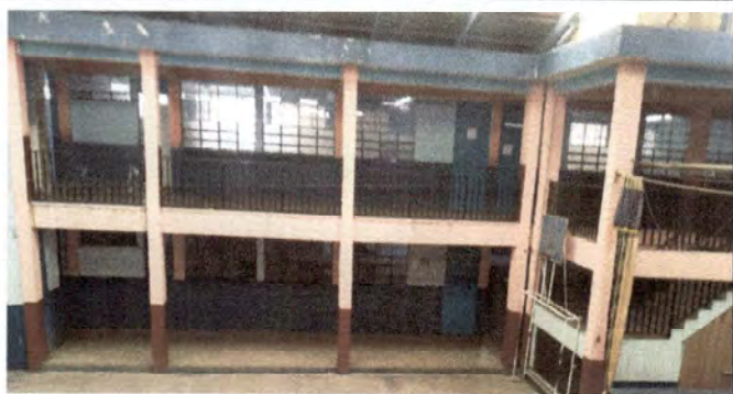
Foto1: Pintada de muros interiores.
