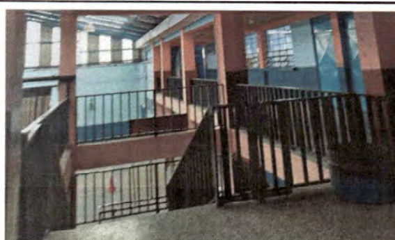
Foto 4: Pintada de barandas
