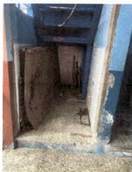
Foto 1: Colocacion de marco y puerta de metal
