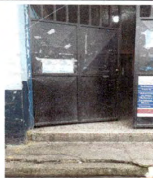
Foto 4: Una rampa en la entrada principal
