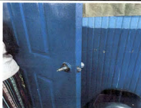
Foto 2: Sustitucion de chapa
