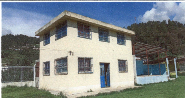
Foto 21: Pintar el edificio de la dirección
