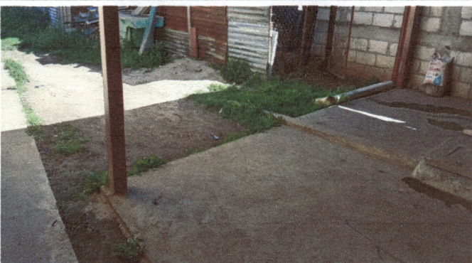
Foto 9: Continuación de pavimento de patio e=0.08M 23.50m2
