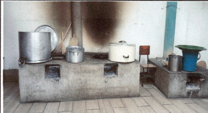
Foto 2: Colocación de azulejos en la estufa de leña en la cocina ALTURA DE 1.20M
