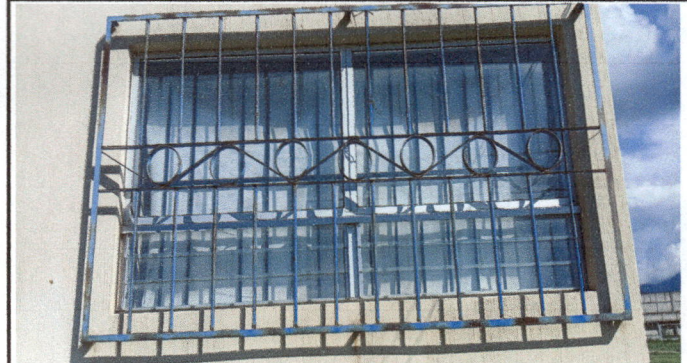
Foto 20: Mantenimiento de Balcones de la dirección
