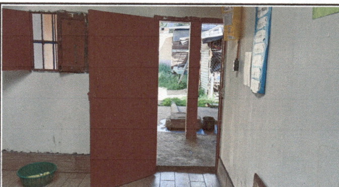
Foto 4: Sustitución de en la cocina de madera 1.84X1.00M, 1.82X0.89M
