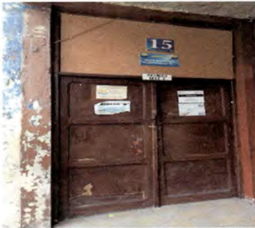
Foto 3: Sustitución de puerta de madera en mal estado por puerta de metal, en el aula No. 15.
