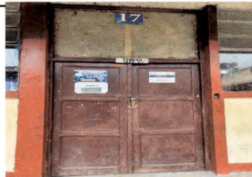
Foto 6: Sustitución de puerta de madera en mal estado por puerta de metal, en el aula No. 17.
