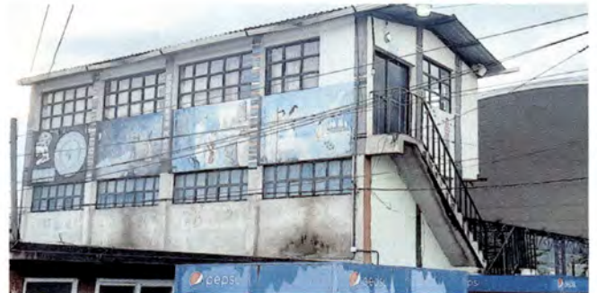
Foto 4: Instalación de balcones de metal en el área de laboratorio de computación del segundo y tercer nivel.
