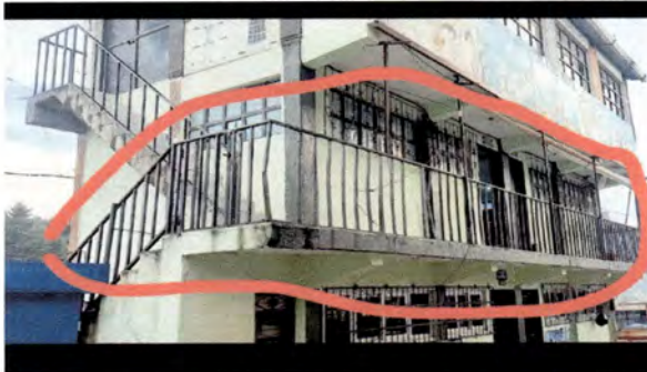
Foto 5: Sustitución de baranda de metal en mal estado por baranda de metal en el área de laboratorio de computación.
