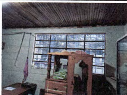
Foto 4: SUSTITUCION DE VENTANA DE METAL A PVC 2 EN COCINA Y 1 EN DIRECCION
