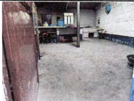
Foto 2: INSTALACION DE PISO DUELA DE 20 X60 EN COCINA
