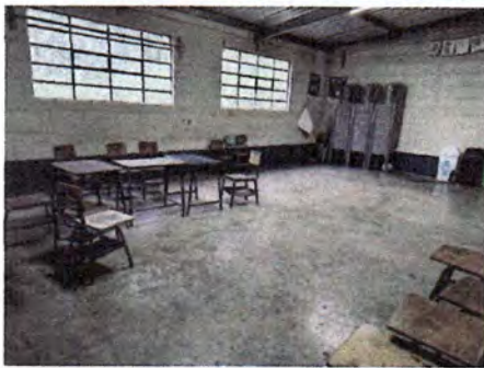
Foto 3: INSTALACION DE PISO CERAMICO DUELA DE 20X60 EN AULAS
