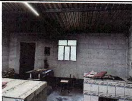
Foto7: REPELLO BASE GRIS Y BLANQUEADO REMOLINEADO EN COCINA
