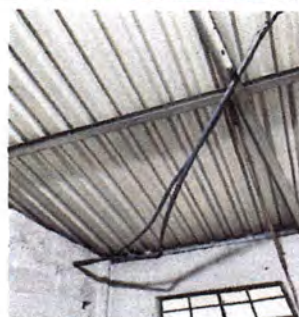
Foto 6: MEJORAMIENTO DE SISTEMA ELECTRICO EN COCINA
