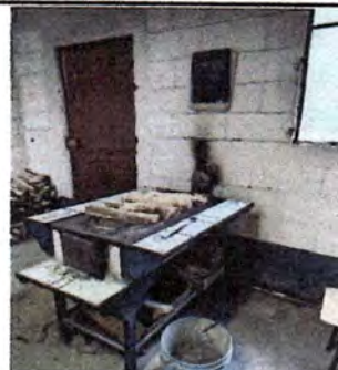
Foto8: SUSTITUCION DE PLANCHA POR PLANCHA DE LEÑA CON CHIMENEA
