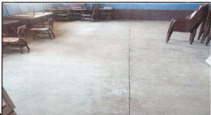
Foto 1: Aula para sustitución de piso
