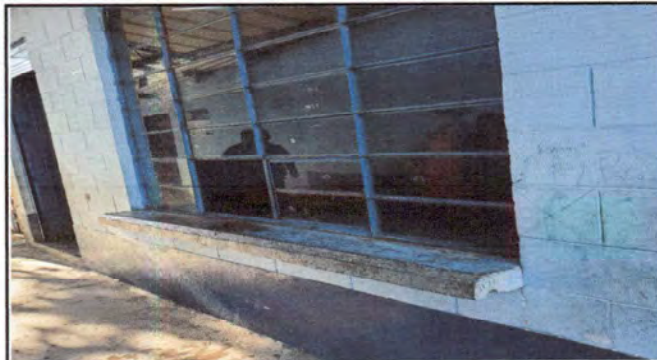
Foto 8: Vista de cocina donde se instala azulejo
