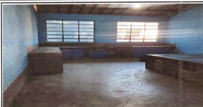
Foto 7: Vista de cocina donde se instala el piso y azulejo.
