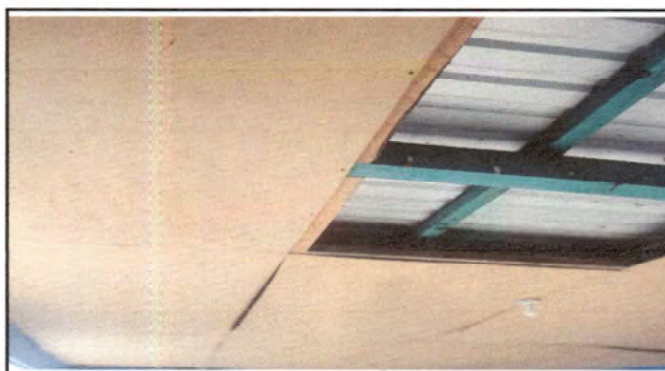
Foto 4: Vista de de donde se va instalar el cielo falso
