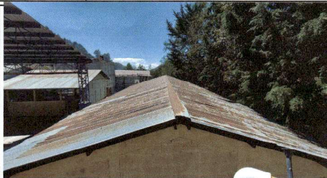
Foto1: CUBIERTA DE LAMINA TROQUELADA DE CALIBRE 26 DE DOS AULAS Y BAÑOS
