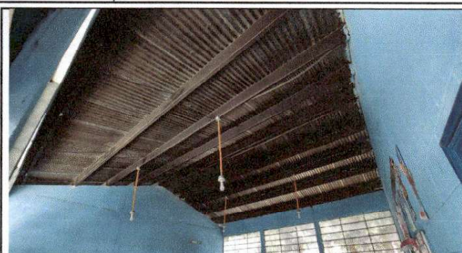
Foto 2: PINTURA EN ESTRUCTURA DE DOS AULAS, CORREDOR Y BAÑOS
