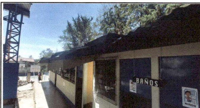
Foto 3: INSTALACIÓN DE CANAL DE PVC EN EL CORREDOR DE DOS AULAS Y BAÑOS.
