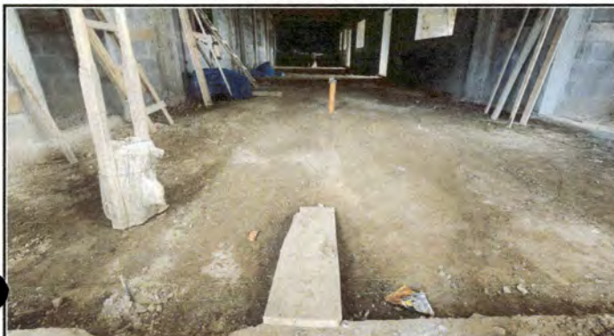
Foto1: Sustrución de piso, por piso de granito en el salón.
