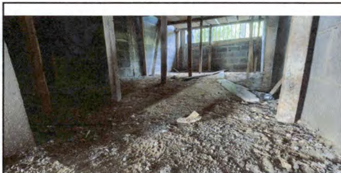
Foto 2: Sustrucion de piso por piso de granito, Dirección lado sur
