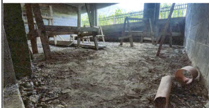
Foto 4: Sustrución de piso por piso de granito, aula 2 lado sur
