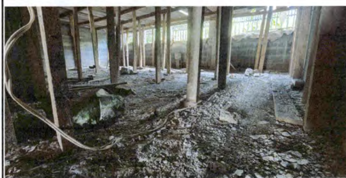
Foto 3: Sustrución de piso por piso de granito, aula 3 lado sur
