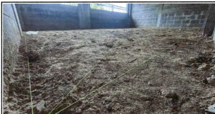
Foto 5: Sustrución de piso por piso de granito, aula 1 lado sur
