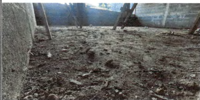
Foto 9: Sustrucción de piso por piso de granito, aula 3 lado norte
