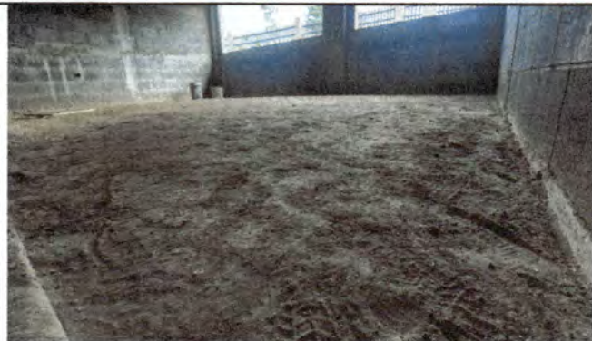
Foto 7: Sustrucción de piso, por piso de granito aula 1 lado norte
