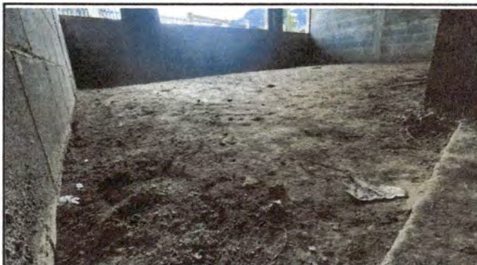
Foto 8: Sustrucción de piso por piso de granito, Aula 2 lado norte
