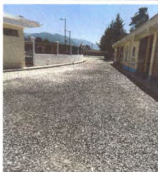
Foto 3: Sustitución de patio en mal estado por patio de adoquin con sus llaves, incluye suministros y mano de obra.
