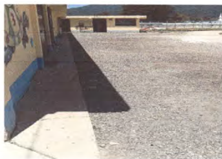
Foto 3: Remozamiento de acera en mal estado por acera de concreto de aulas y dirección, incluye material y mano de obra
