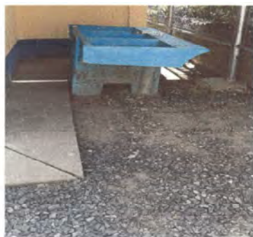
Foto 1: Remozamiento de pila consistente en arreglo de base y mantenimiento de desagüe incluye material y mano de obra.
