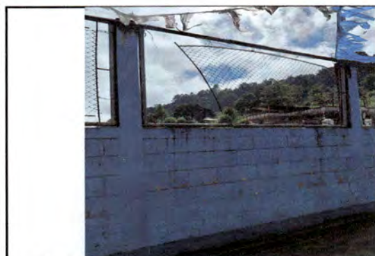
Foto 5: Sustrucción de mallas por barandas.
