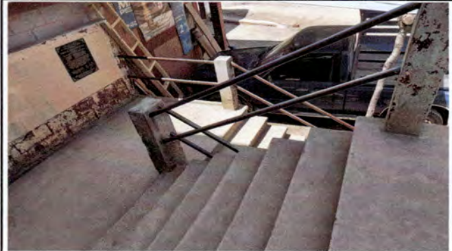
Foto14: Mantenimiento de pintura para barandas.
