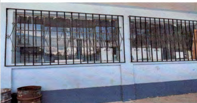
Foto15: Mantenimiento de pintura a 2 balcones de ventanas de un aula.
