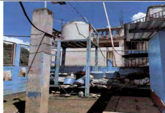
Foto16: Mantenimiento de pintura a la base de Rotoplas.
