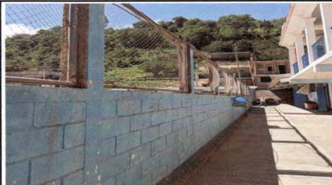
Foto 8: Pintado de exterior
