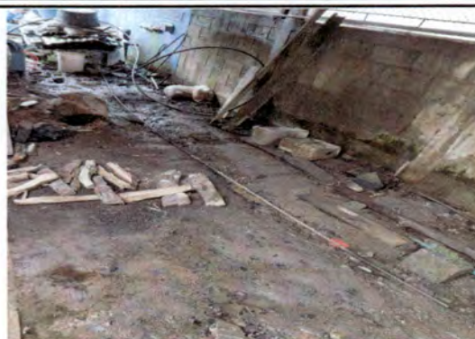
Foto 2: Sustrucción de adoquines hundidos y cuneta por losa y nueva cuneta.
