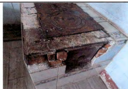
Foto 4: Demolición de 2 planchas, por 2 planchas integradas.
