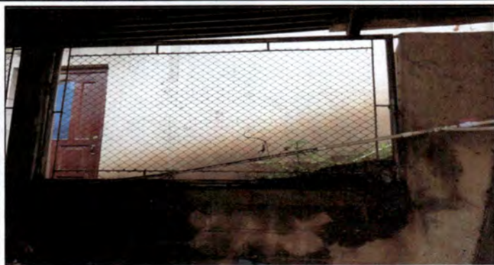
Foto1: Sustrucción de malla grande por una más pequeña y 3 hileras de block.
