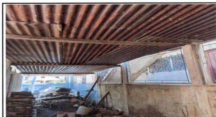
Foto 3: Sustrucción de láminas y tendales por estructura de metal.
