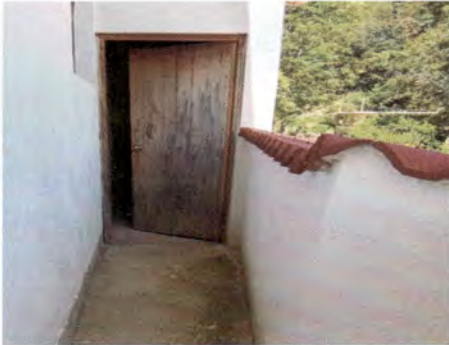
Foto13: Sustrucción de la puerta de madera por una puerta de metal.
