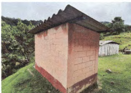
Foto 3: Cambio de lámina duralita deteriorada por lámina troquelada en el sanitario de la escuela
