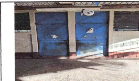
Foto 11: Puertas de las aulas que se pintarán
