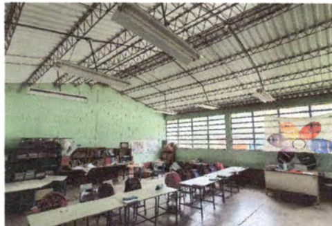
Foto 4: cambio de lámparas tubulares colgantes por nuevas lámparas led con base de metal en cada aula
