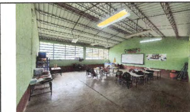
Foto 9: interior de una de las aulas que se pintará
