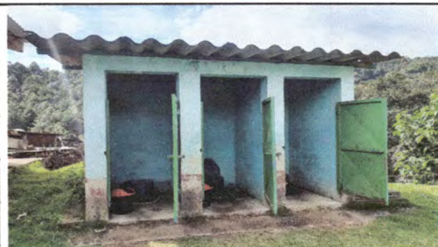
Foto 10: sanitarios y puertas que se pintarán
