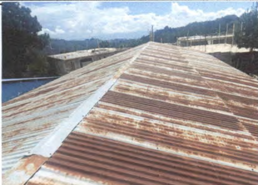
Foto1: Cambio de techo de un modulo de 2 aulas y dirección
