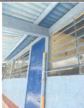
Foto 6: Cambio de tubo de caída de agua PVC
