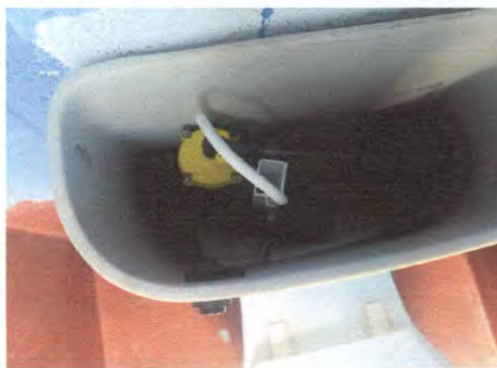
Foto 2: Sustitución de Taza Sanitaria de los baños
