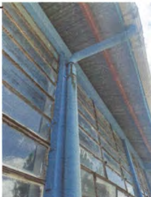
Foto 4: Cambio de tubo de caída de agua PVC
