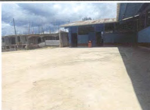
Foto 3: Reparación de Patio por grietas
