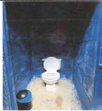
Foto 2: Instalación de piso azulejo y pintura en baños.
