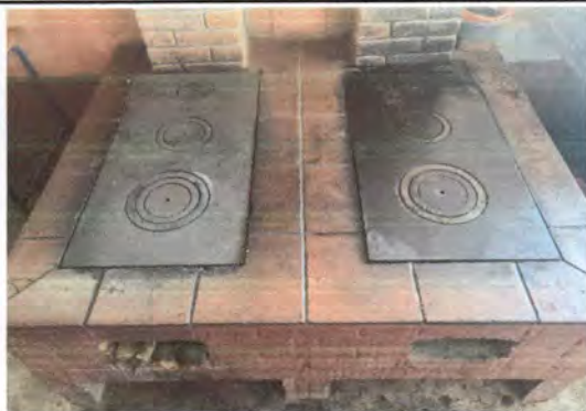
Foto 19: Sustrucción de plancha de 3 ornillas e instalación de azulejo en cocina.
