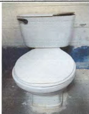
Foto 9: Sustitución de un Inodoro en baño 4.
