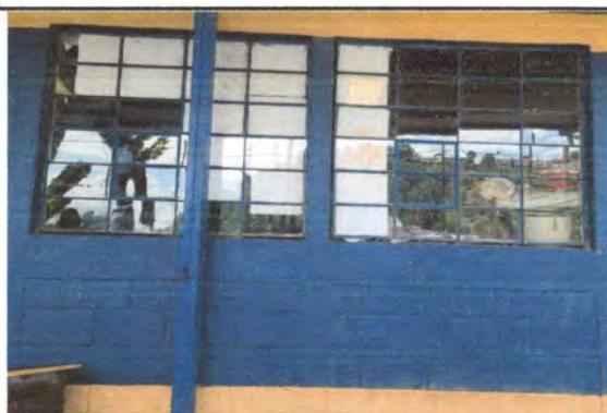
Foto 16: Instalación de balcones en ventana del aula.
