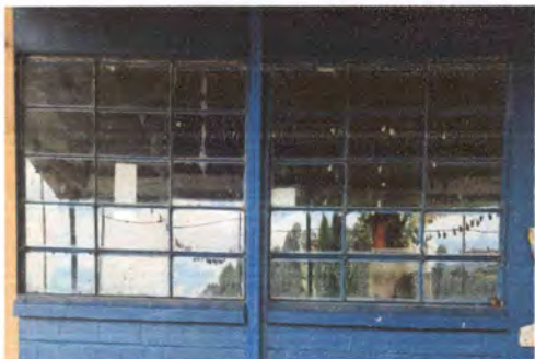
Foto 5: Sustitución de ventanas en aulas.
