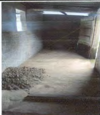
Foto13: Instalación de piso, repello y pintura en paredes de bodega.
