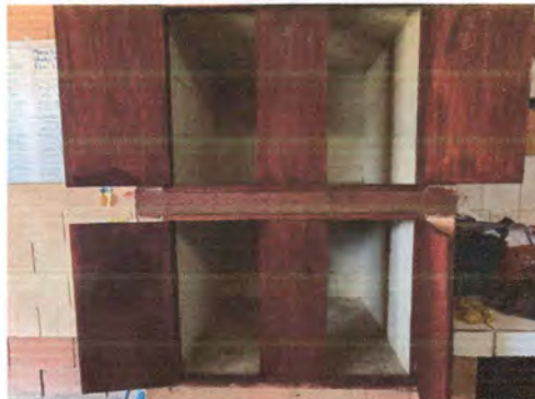
Foto 8: Instalación de azulejo y sustitución de puertas en mueble de cocina.
