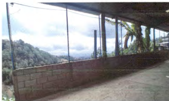
Foto 14: Repello en las paredes y pintura de muro de patio.
