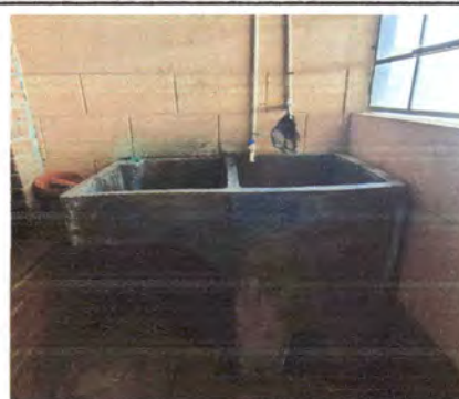
Foto 10: Sustitución de pila de un lavadero.
