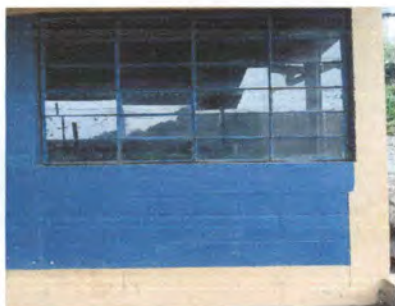
Foto 15: Instalación de balcones en cocina.
