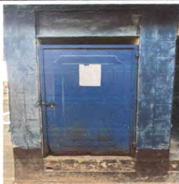
Foto 3: Sustitución de puerta de metal en baños.
