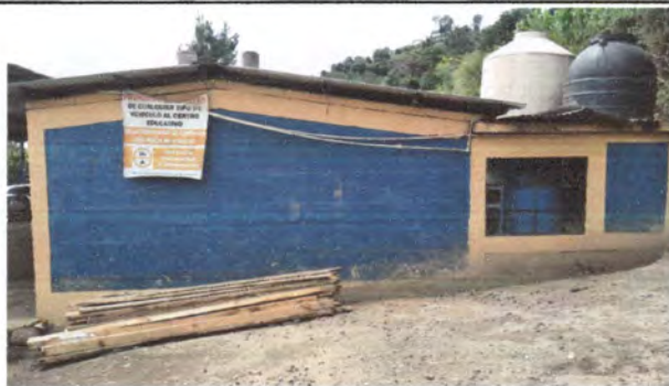
Foto 11: Pintura del área exterior del Establecimiento.
