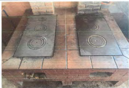
Foto 7: Sustitución de plancha de 3 ornillas e instalación de azulejo en cocina.
