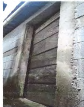
Foto 4: Sustitución de puerta de bodega.
