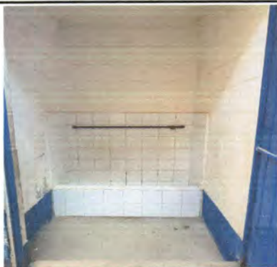
Foto1: Instalación de piso azulejo y pintura en baños.
