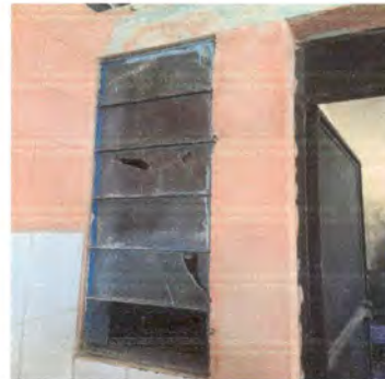
Foto 6: Sustitución de ventanas en cocina.
