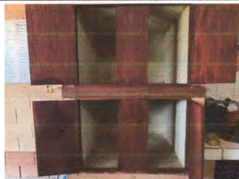
Foto 20: Instalación de azulejo y sustitución de puertas en mueble de cocina.
