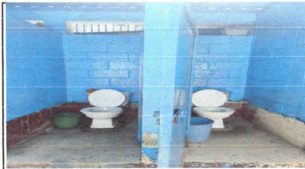
Foto 20: Sustitución de piso de cemento por piso antiestático e instalación de azulejo sanitario
