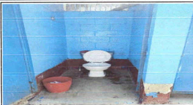
Foto 19: Sustitución de piso de cemento por piso antiestático e instalación de azulejo sanitario
