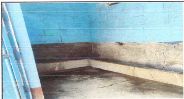
Foto 21: Sustitución de piso de cemento por piso antiestático e instalación de azulejo sanitario.
