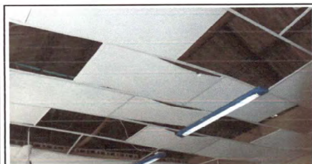
Foto 17: Sustitución de cielo falso UPVC de aulas
