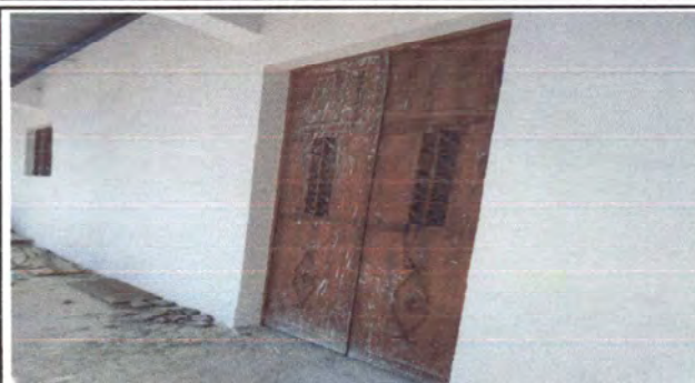
Foto 14: Repintado de puertas de aulas de azul nacional salón de actos
