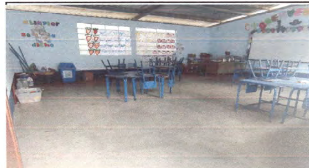
Foto 4: Sustrucción de piso de cemento por piso cerámico de aula 5
