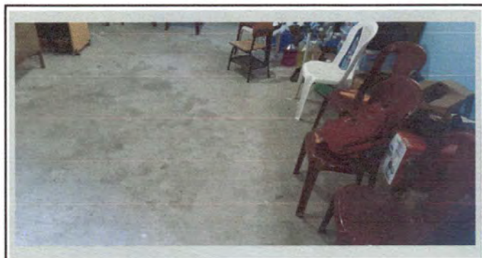
Foto 7: Vista de la Dirección del establecimiento que requiere instalación de piso
