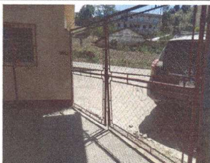
Foto 3: MANTENIMIENTO DE UN PORTÓN
