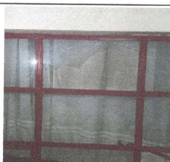
Foto 4: COLOCACIÓN DE VIDRIOS DE DIFERENTES TAMAÑOS
