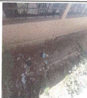
Foto 5: ALISADO DE PARED DE BLOCK DE 60.90 M DE LARGO X 0.75 M DE ALTURA.
