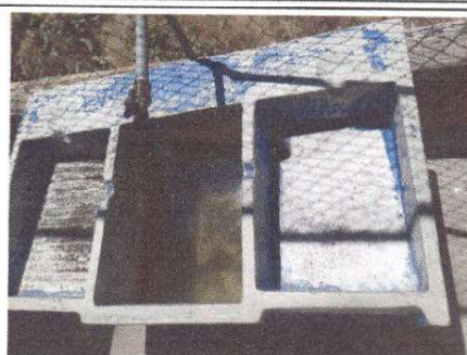
Foto 2: SUSTITUCIÓN DE LAVADERO PEQUEÑO.
