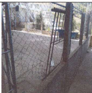
Foto 5: SUSTITUCIÓN DE CERCO DE MALLA.
