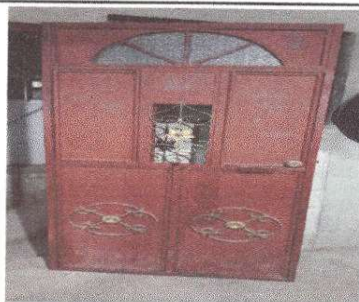
Foto 3: MANTENIMIENTO DE 2 PUERTAS.
