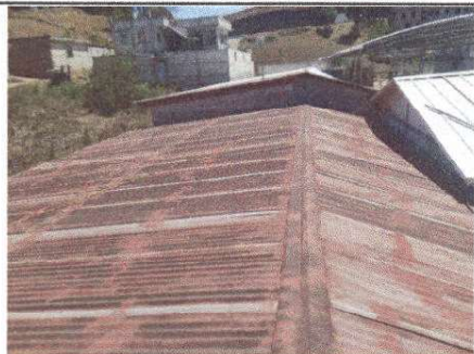
Foto 1: SUSTITUCION DE CUBIERTA DE LAMINA ACANALADA POR LAMINA TROQUELADA Y MANTENIMIENTO DE COSTANERAS Y COLOCACION DE TUBERIAS DE CANAL PVC.
