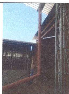
Foto 6: SUSTITUCIÓN DE TUBOS PARA CANALETAS Y BAJADA DE AGUA
