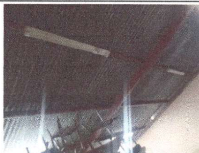
Foto 6: MANTENIMIENTO DE INSTALACIONES ELECTRICAS EN 3 AULAS, BODEGA
