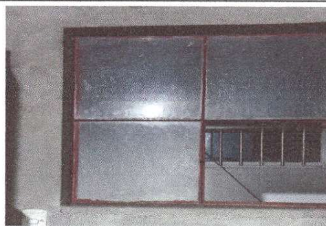
Foto 4: SUSTITUCIÓN DE UNA VENTANA
