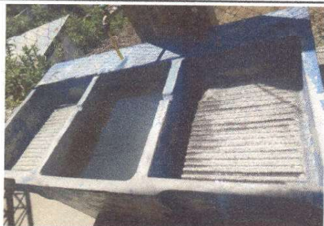
Foto 1: MEJORAMIENTO DE DRENAJE Y SUSTITUCIÓN DE LAVADEROS
