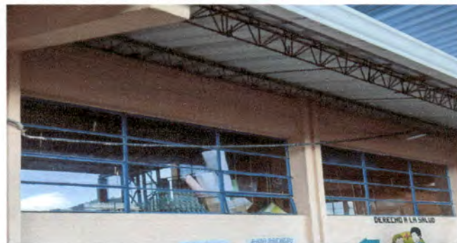
FOTO 2. INSTALACIÓN DE BALCONES PARA PROTEGER LAS VENTANAS DE UN AULA EXPUESTA EN EL PATIO
