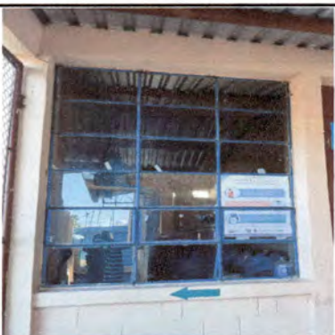
FOTO 3. INSTALACIÓN DE BALCÓN PARA LA PARTE DE ENFRENTA DE LA VENTANA DE LA BODEGA
