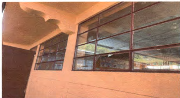
Foto 1. INSTALACIÓN DE BALCONES PARA PROTEGER LAS VENTANAS DE UN AULA EXPUESTA EN EL PATIO
