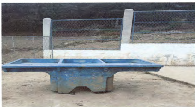
FOTO 15. SUSTITUIR LAVADERO POR LAVAMANOS DE CONCRETO
