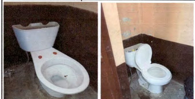
FOTO 12. SANITARIOS EN MAL ESTADO Y NECESIDAD DE AZULEJOS.
