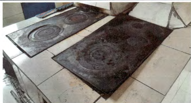
FOTO 11. PLANCHAS Y AZULEJOS DE LA ESTUFA DE LEÑA EN MAL ESTADO
