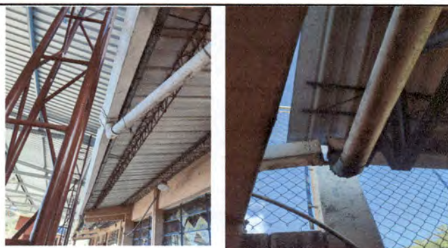
FOTO 18. CANALES Y BAJADAS DE AGUA EN MAL ESTADO
