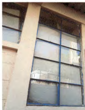
FOTO 4. INSTALACIÓN DE BALCÓN PARA LA PARTE DE ATRÁS DE LA VENTANA DE LA BODEGA
