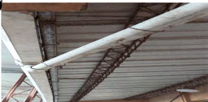
FOTO 5. ESTRUCTURA METÁLICA OXIDADA BAJO LA LÁMINA DEL CORREDOR DE 2 AULAS
