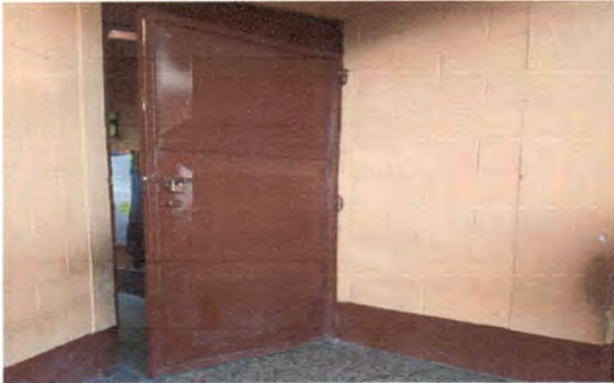
FOTO 7. MANTENIMIENTO DE PUERTAS SUCIAS DE TODAS LAS INSTALACIONES
