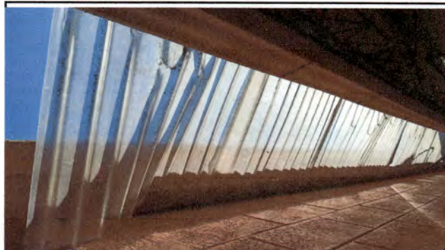
FOTO 6. LÁMINA TRAGALUZ EN MAL ESTADO SOBRE LOS LAVAMANOS
